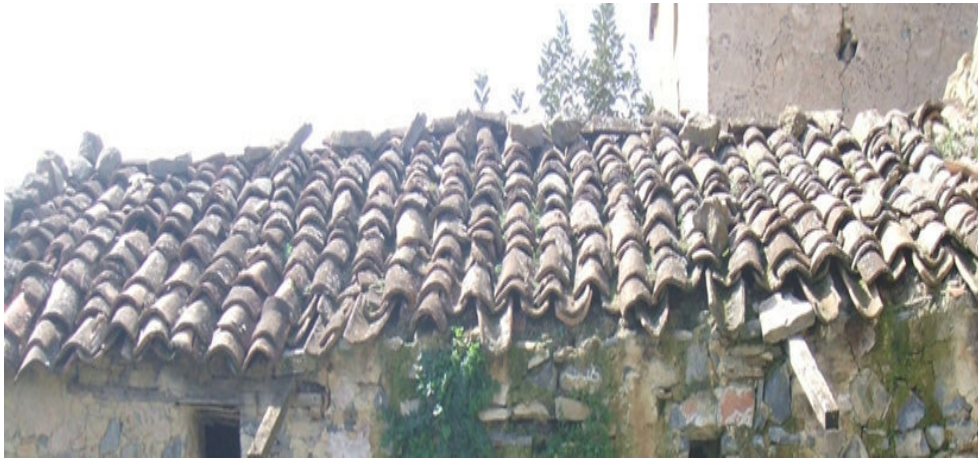
الصورة رقم(50): القرميد في تسقيف المنازل.
