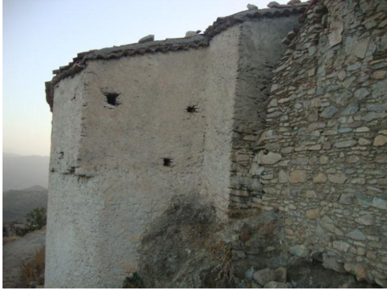
الصورة رقم(70): التسقيف المائل.
