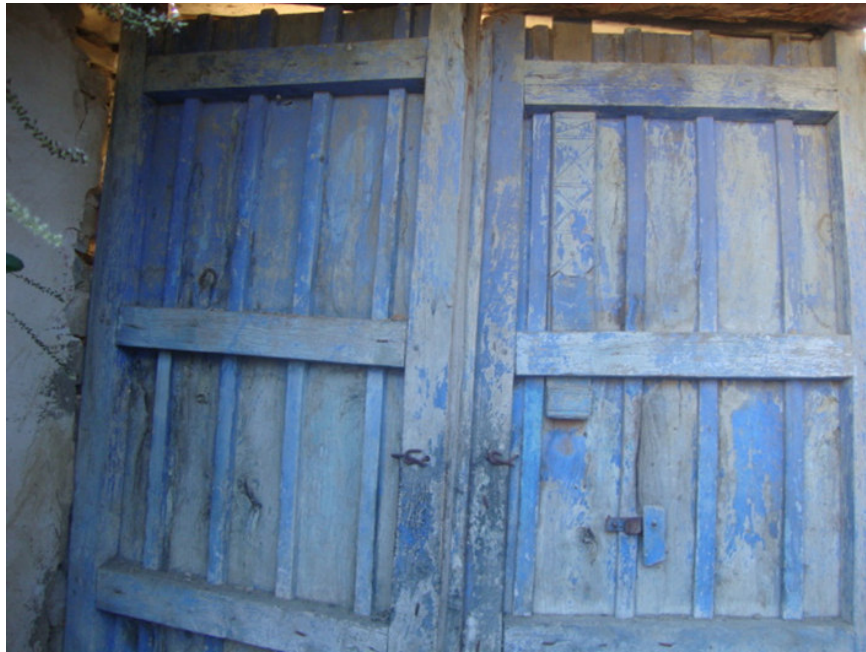
الصورة رقم(46): مادة الخشب في صنع العناصر المعمارية.
