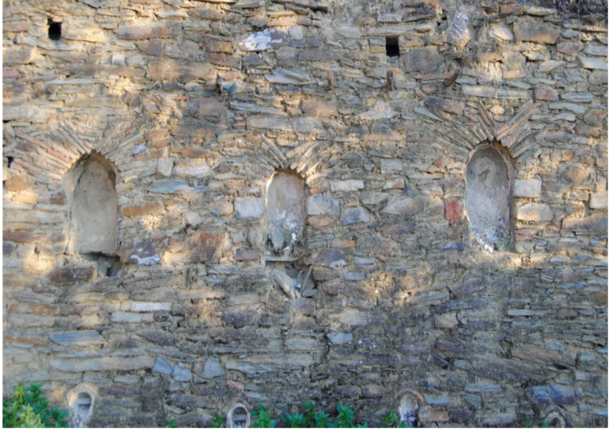
الصورة رقم(60): تقنية المداميك المائلة.
