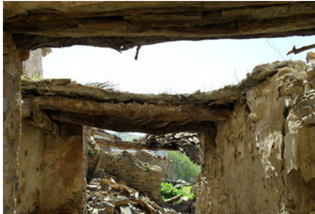
الصورة رقم (69): التسقيف المسطح.
