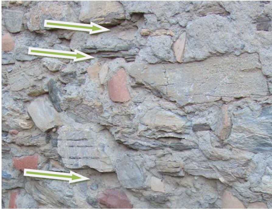
الصورة رقم(83): تآكل الملاط بفعل الرياح.
