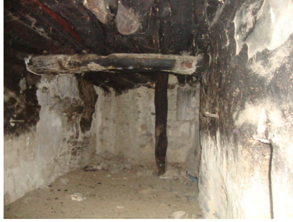
الصورة رقم (68): التسقيف المسطح.
