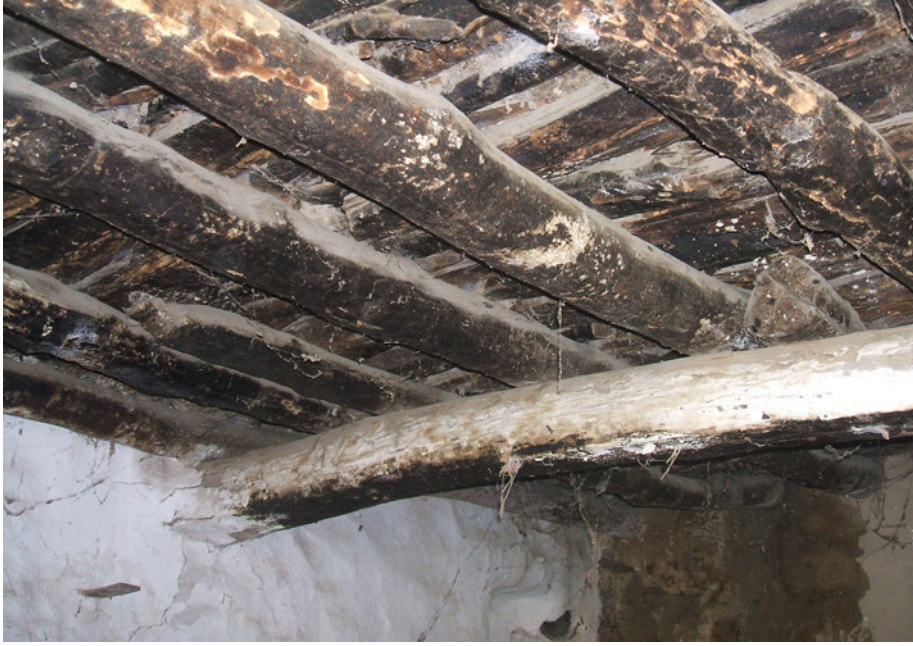
الصورة رقم(45): مادة الخشب في بناء السقف.
