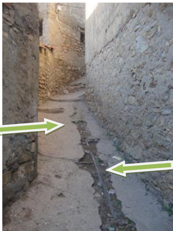
الصورة رقم(95): استعمال الاسمنت في الشوارع بعد إدخال الماء إلى القرية.
