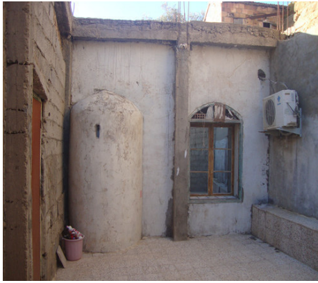
الصورة رقم(13): فناء المسجد.
