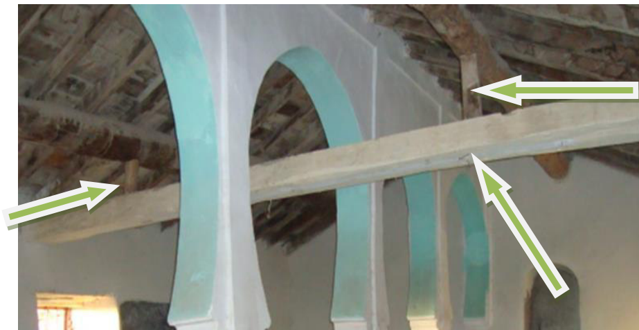
الصورة رقم(125): تدعيم السقف.
