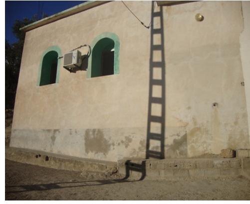
الصورة رقم(12): الجهة الجنوبية للمسجد.
