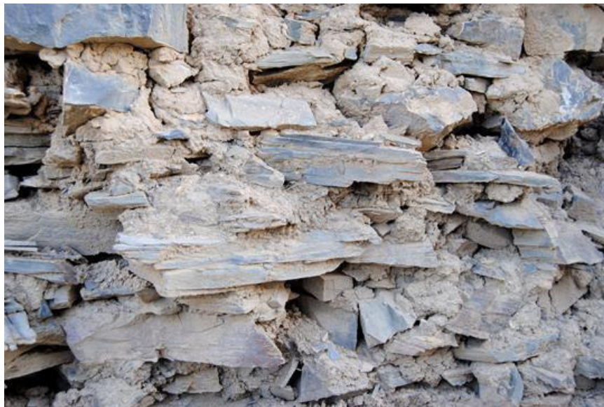
الصورة رقم(78): تفتت الملاط الرابط للحجارة.
