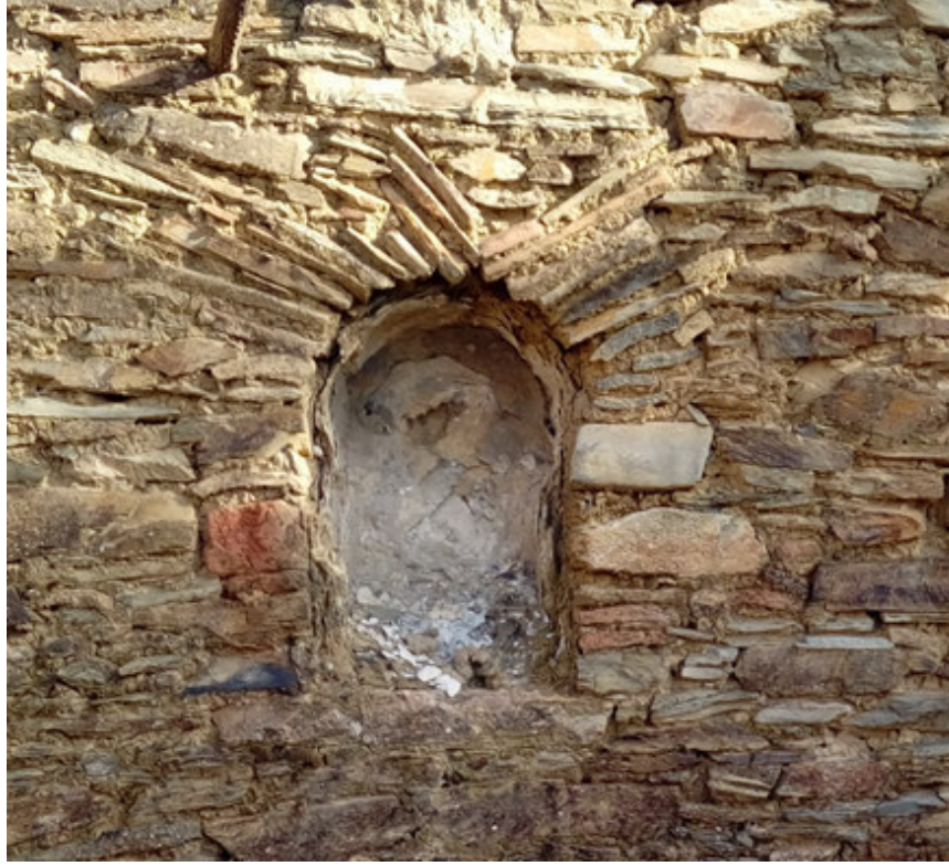
الصورة رقم(59): تقنية المداميك المزدوجة.
