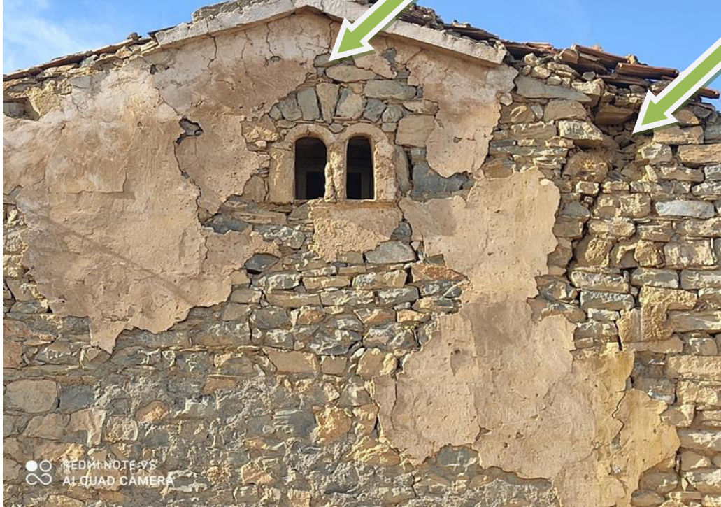
الصورة رقم(77): تفتت الملاط وتشققات على مستوى الجدار الخارجي بسبب السيول والأمطار.
