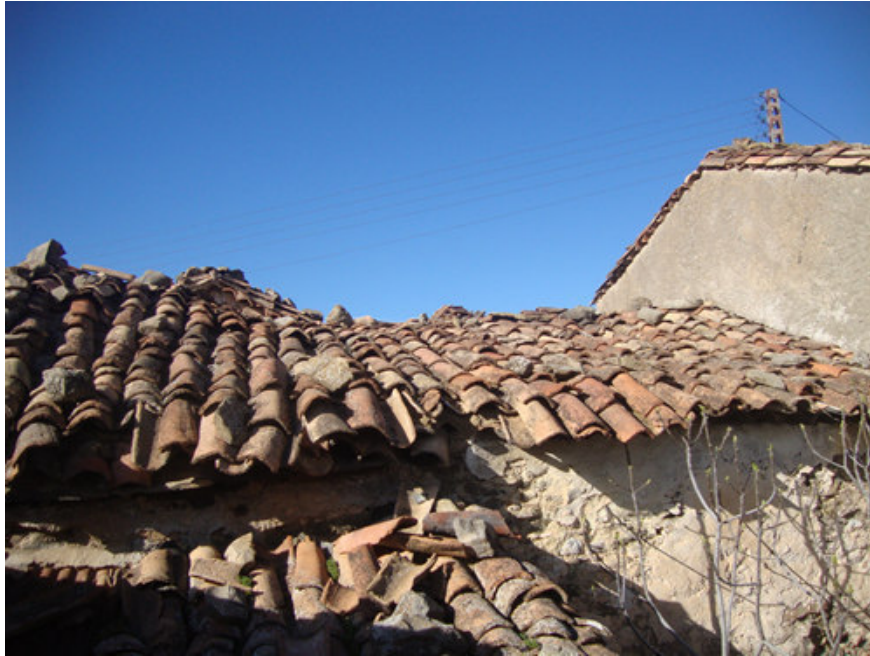
الصورة رقم(73): التسقيف الجمالوني بالمباني التقليدية.
