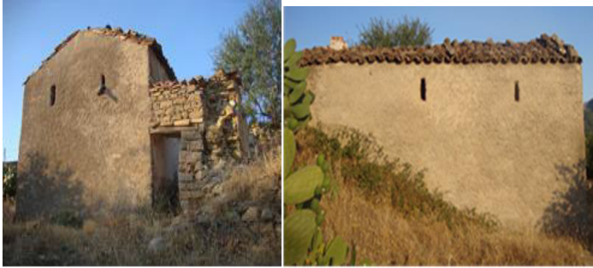
الصورة رقم(119): تكسية جدران المباني التقليدية بالإسمنت.
