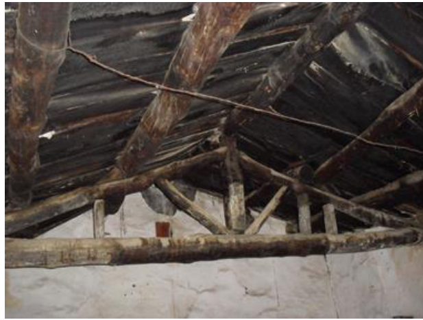
الصورة رقم(124): تدعيم السقف.
