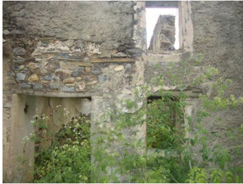
الصورة رقم(98): نمو النباتات في المنشآت التقليدية.
