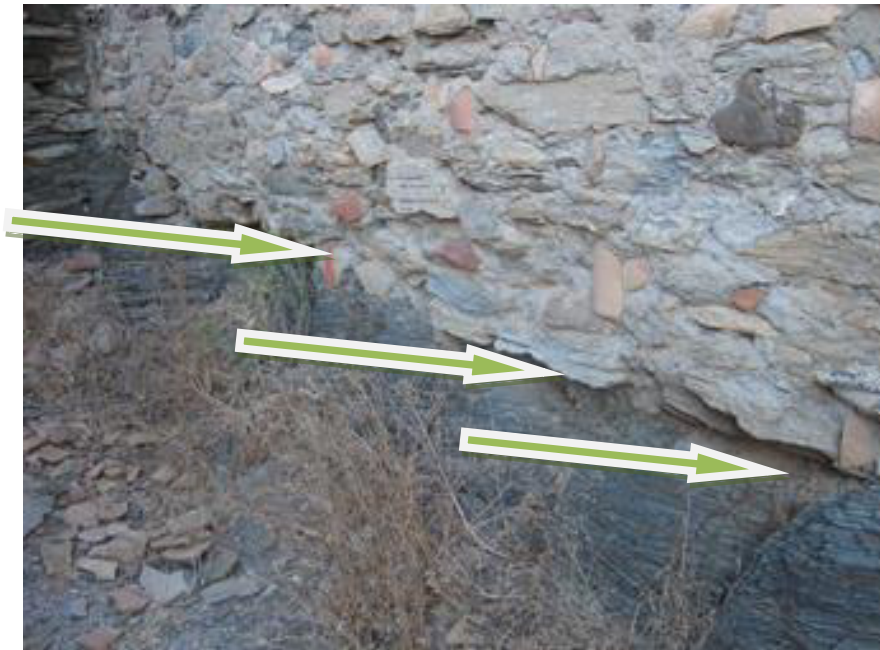
الصورة رقم (80): نزع الأتربة في الأساس بفعل السيول والأمطار.
