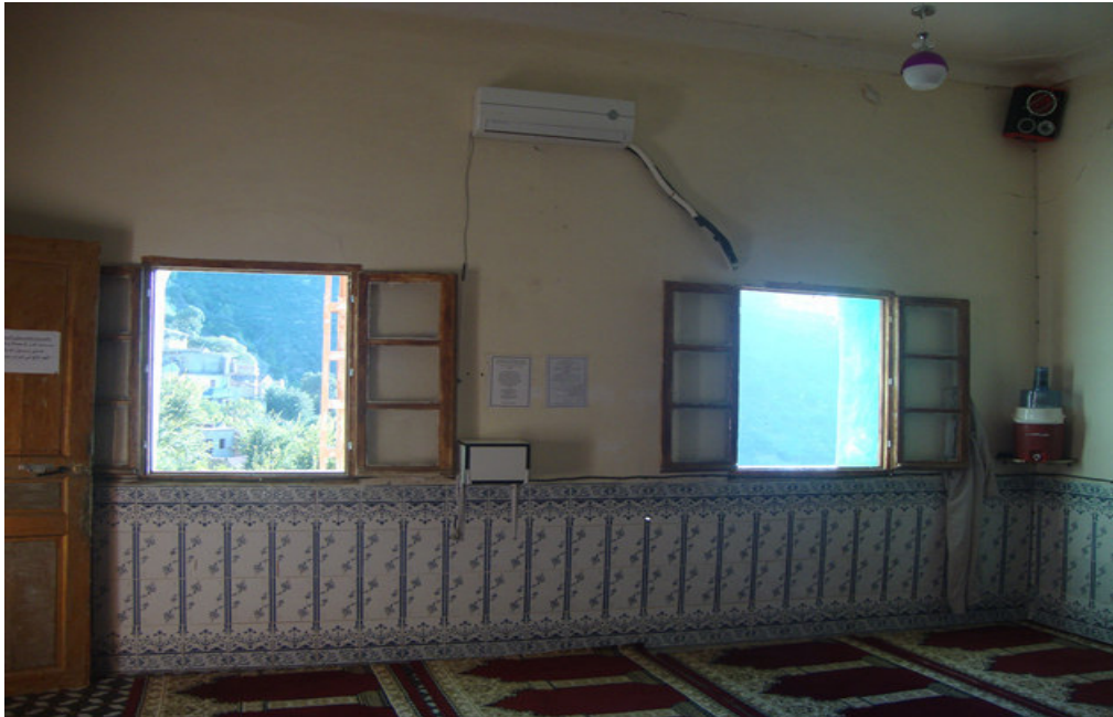
الصورة رقم(18): الجدار الجنوبي للمسجد.
