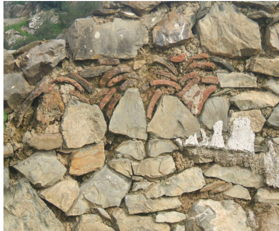
الصورة رقم(63): تقنية المزج بين المواد البنائية.
