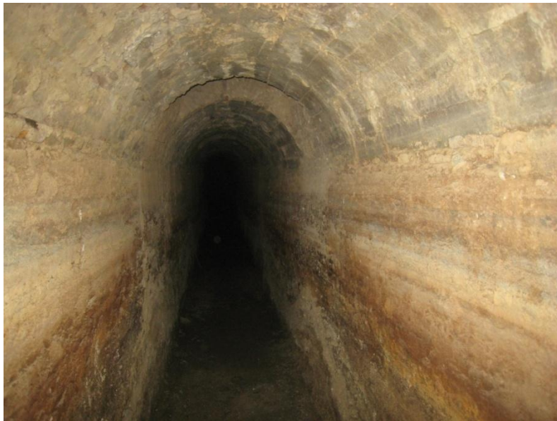
شكل 34.2: صورة من داخل النفق
