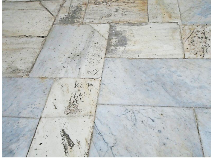
الصورة (115) : توضح تبليط أرضية صحن المدرسة المتوكلية
