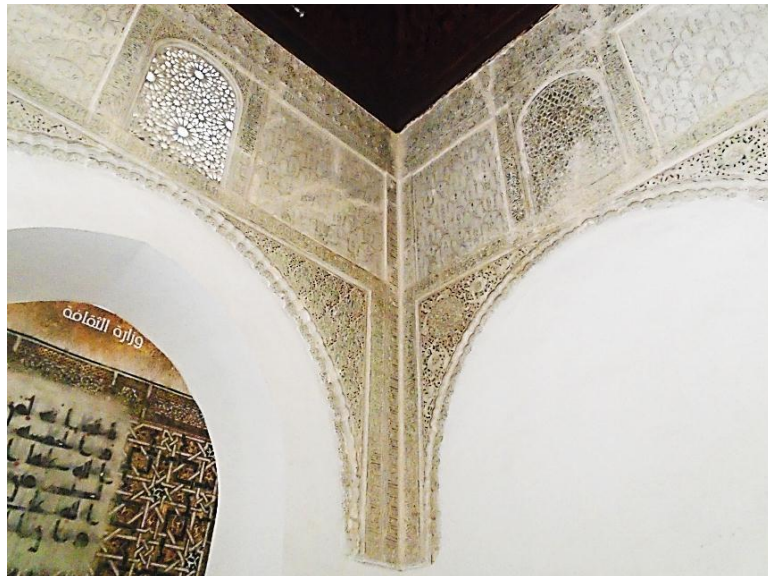
الصورة (91): الواجهات الداخلية العلوية لجامع أبي الحسن (عمل الطالب)
