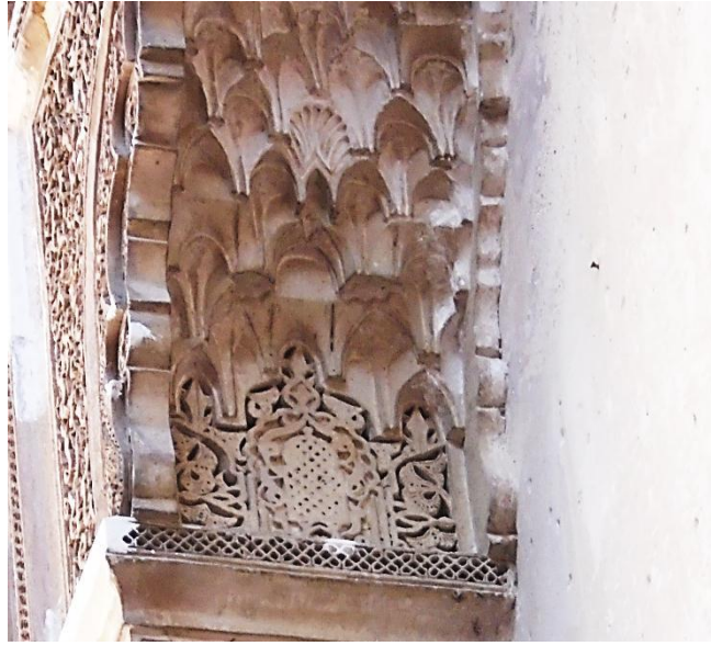
الصورة (83): عنصر المقرنصات بمدرسة الصهريج
