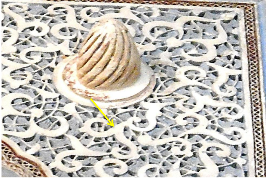
الصورة (153): توضح نوعا من المرواح بمسجد العباد المريني.
