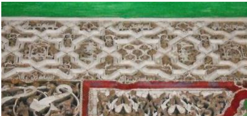
الصورة (206) : توضح نوع من شبكة المعينات الصماء بقبة محراب جامع المنصور (عمل الطالب)
