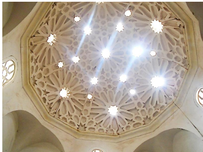
الصورة (88) : القبة التي تتقدم المحراب بجامع سيدي الحلوي (عمل الطالب)
