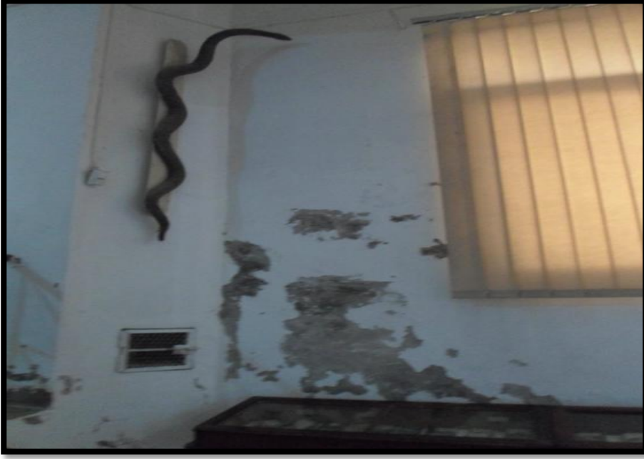
الصورة رقم 01 آثار الرطوبة على جدران القاعة
