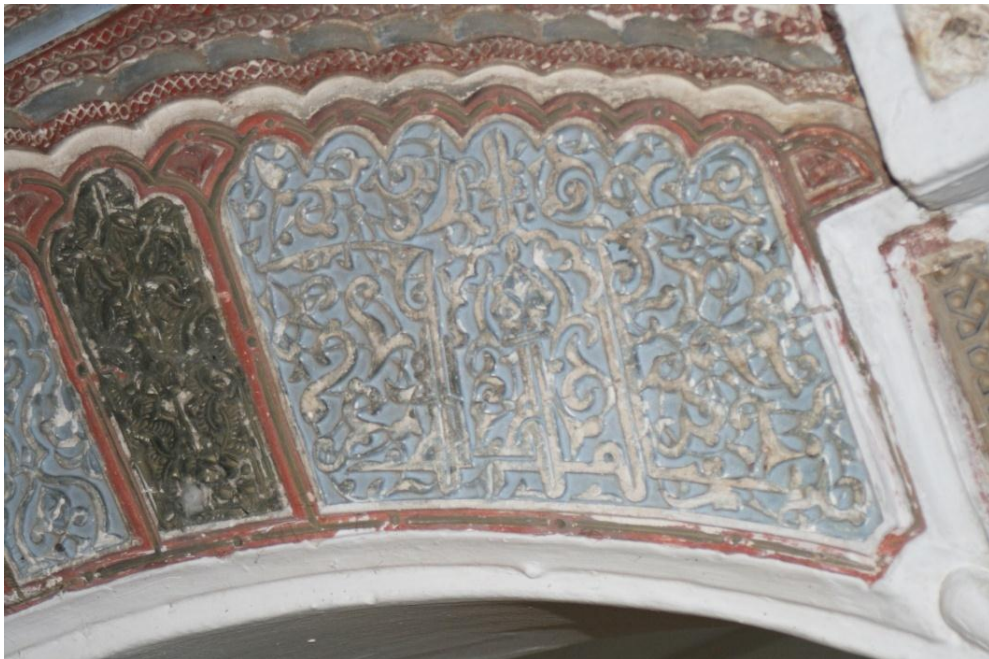
صورة رقم 81- الزخرفة الكتابية التي تزين صنجة منبت العقد مسجد سيدي أبي مدين بتلمسان (من عمل الطالبة)
