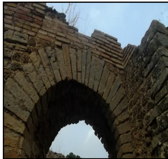
الصورة رقم 15: قوس بالحمامات الكبرى منجز بالتقنية القائمة على الأجر
