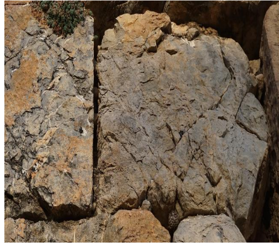
الصورة رقم 77: نقش حجارة المداميك العلوية للمسرح بفعل الجليد الصورة رقم 78: نقش حجارة المعبد السفلى بفعل دورات التجمّد والذوبان
