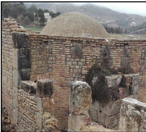
الصورة رقم 16: الجدران الخارجية للمعمودية منجزة بالتقنية القائمة على الأجر
