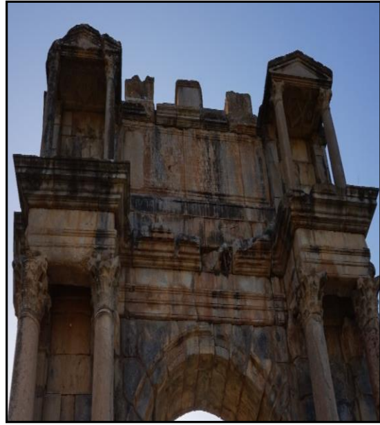
الصورة رقم 74: توضح ظاهرة تشكّل بقع سوداء على مستوى قوس كركلا
