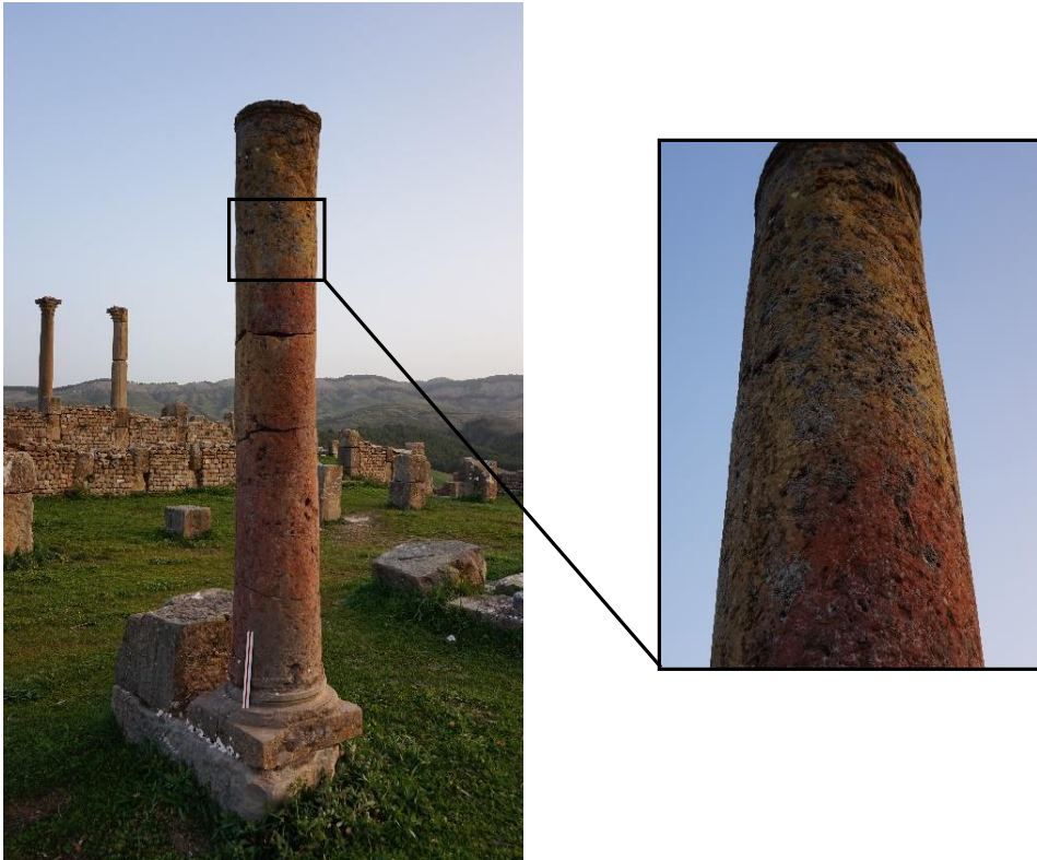
الصورة رقم 6: تبين أعمدة من حجارة الترافونتين ذات اللون المَعْرَة المَحْمَرُ على مستوى بازيليك كروسكنيوس بالحي المسيحي
