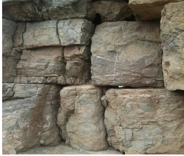
الصورة رقم 79: تبيين التشقق والانفصال والتجزؤ بفعل الجليد على مستوى المسرح
