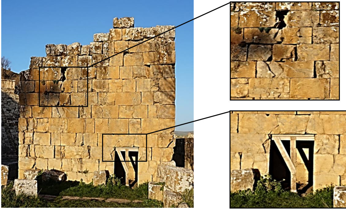
الصورة رقم 22: توضح تشقق الحجارة تحت تأثير الأحمال في أحد جدران المسرح
