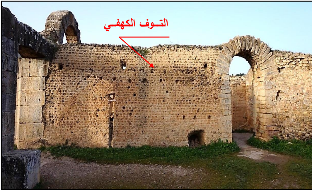
الصورة رقم 3: حجارة التوف الكهفي المستخدمة كدبش في جدران الحمامات الكبرى
