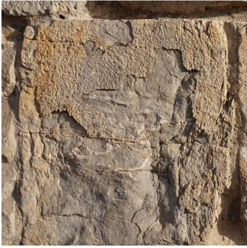
الصورة رقم 77: نقش حجارة المداميك العلوية للمسرح بفعل الجليد الصورة رقم 78: نقش حجارة المعبد السفلى بفعل دورات التجمّد والذوبان
