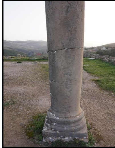
الصورة رقم 60: تبين انفصام في أعمدة بشكل أفقي إلى عدة أجزاء على مستوى بازيليك كروسكنيوس بالحي المسيحي
