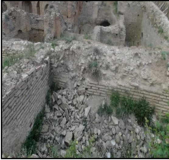
الصورة رقم 27: توضح تهدم أحد جدران الحمامات الكبرى تحت تأثير مياه الأمطار
