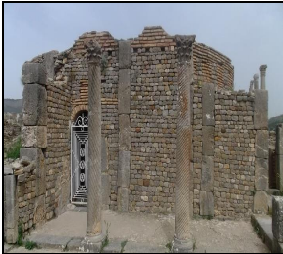
الصورة رقم 12: تبين تقنية البناء الإفريقية في جدران المعمودية بالحي المسيحي
