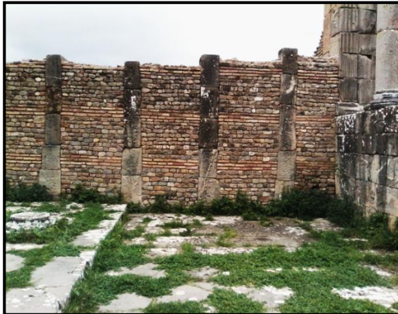
الصورة رقم 20: تبين جدار منجز بتقنية البناء المختلطة (التقنية الإفريقية مع الآجر) في مبنى معبد فينوس جينيتريكس
