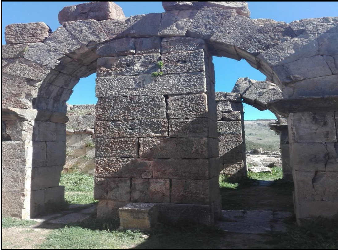
الصورة رقم 48: تبين عيوب التّدخلات الخاطئة على مستوى الكابيتول (غياب حجارة مفتاح القوس وإنجاز جدار لدعم القوس)
