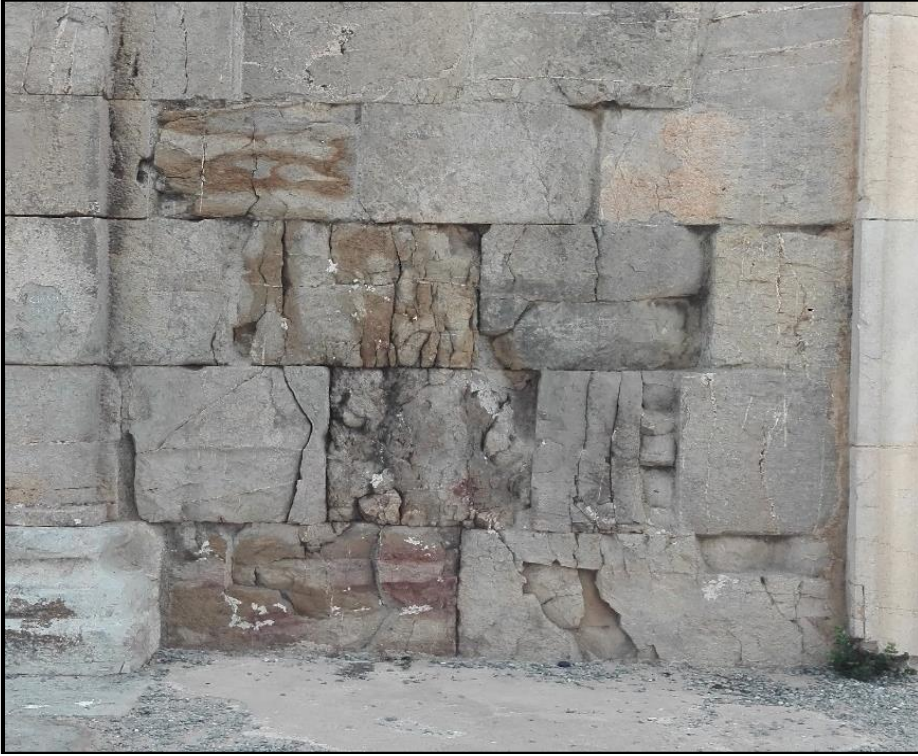
الصورة رقم 53: توضح تدهور الحجارة بشكل عمودي للأحمال للمداميك السفلى على مستوى مدخل المعبد السيفيري (الجهة الشمالية)
