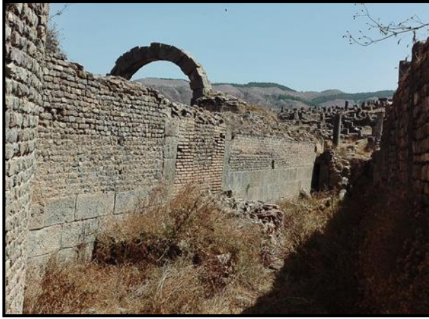
الصورة رقم 18: تبين استخدام أكثر من تقنية بناء (النظام الكبير، التقنية المختلطة) في إحدى جدران الحمامات الكبرى
