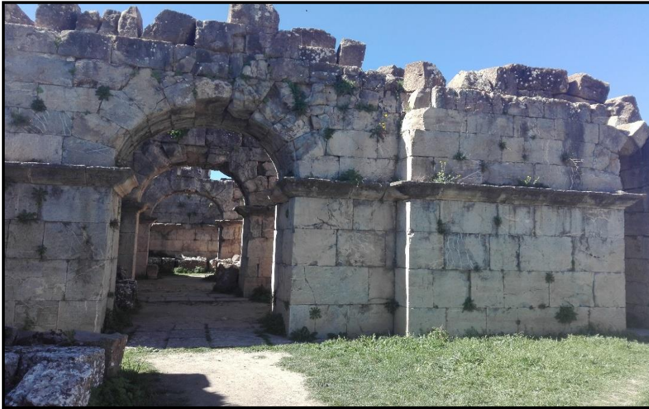
الصّورة رقم 13: تبين جدار منجز بتقينه النّظام الكبير على مستوى الكابيتول
