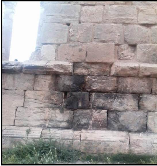
الصورة رقم 31: تبين صعود الماء بالخاصية الشعرية في قاعدة جدار للمعبد السيفيري
