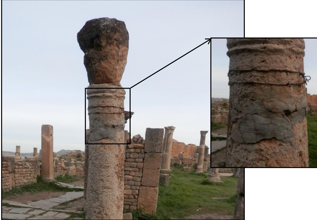
الصورة رقم 50: توضح استخدام الإسمنت والأسلاك المعدنية في ترميم وتدعيم عمود متواجد بمبنى بيت الأسقف والكاهن (المخطط رقم 1)
