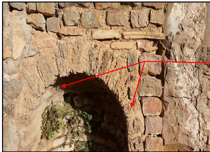
الصورة رقم 4: حجارة التوف الكهفي المستخدمة كدبش في قوس المدخل الشرقي للمعمودية
