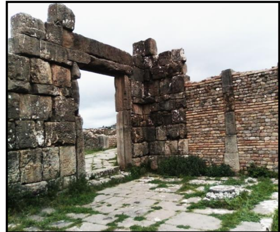
الصورة رقم 19: تبين استخدام أكثر من مادة (الكتل الحجرية مع الدبش والآجر) الجدار الغربي لمعبد جينتركس
