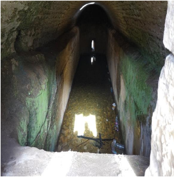
الصورة رقم 41: تبين نمو الطحالب الخضراء في إحدى أقبية الحمامات الكبرى
