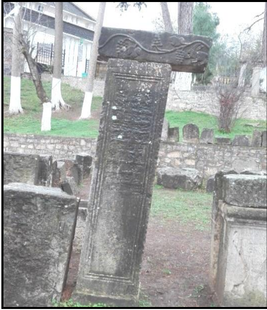
الصورة رقم 75: تبين تشكّل قشور سوداء على نصب تذكاري بحديقة الموقع الأثري
