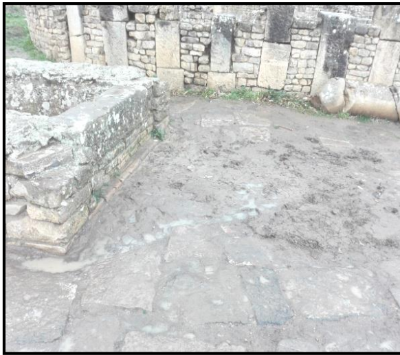
الصورة رقم 29: توضح تجمع الأوحال بالمدخل الجنوبي للموقع الأثري
