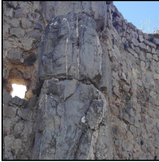
الصورة رقم 58: تبين تشقق وتشرخ الكتل الحجرية لجدار بالحمامات الكبرى
