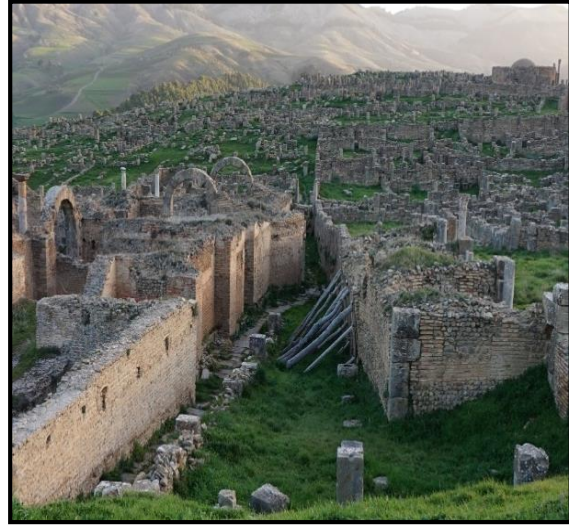
الصورة رقم 26: توضح ميلان إحدى جدران الحمامات الكبرى بسبب الأمطار
