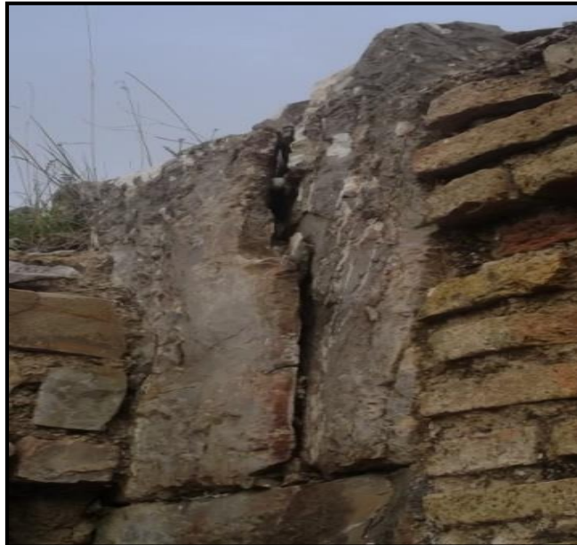
الصورة رقم 61: تبين ظاهرة الانفصال المتوازي للحجارة في جدار بالحمامات الكبرى
