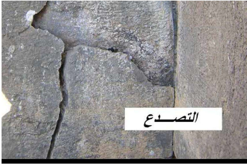
الصورة رقم 14: أحد أشكال التصدع.
