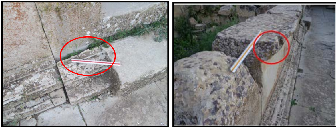
الصورة رقم 26: انفصال النتوءات السفلية ونمو الأشنات
