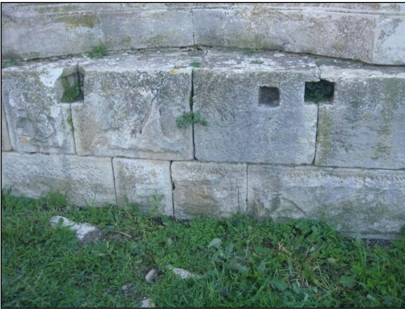
الصورة رقم 13: حفر تثبيت الروافد الخشبية
