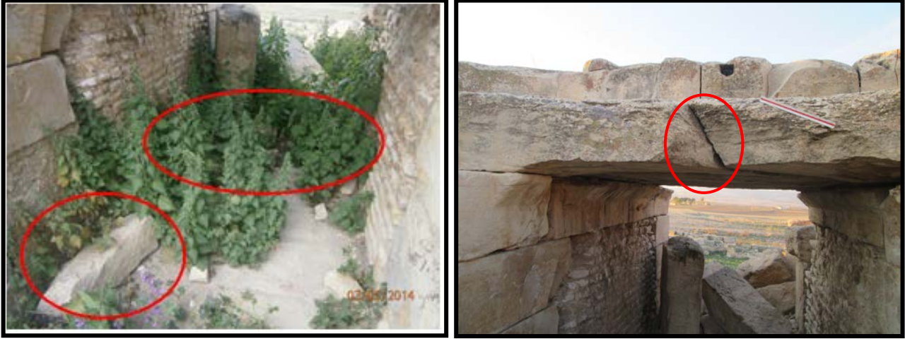
الصورة رقم 36: نمو الحشائش وسقوط الأحجار
