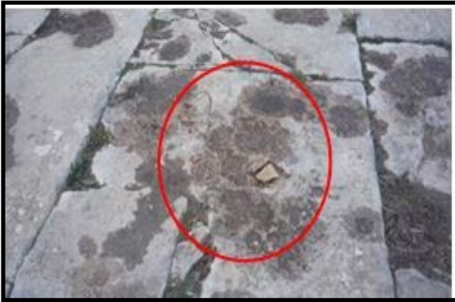
الصورة رقم 28:ترسب الماء على سطح البلاطات
