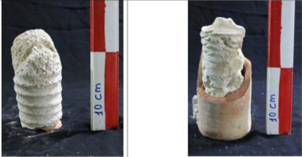
صورة رقم 12 و 13: عينات من الانابيب الفخارية التي استخدمت في تنفيذ القواس أو الأسقف المقببة محفوظة بالمتحف العمومي الوطني عبد المجيد مزيان بالشلف.
