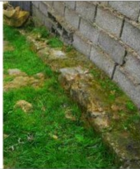
صورة رقم 3: بقايا الجدار الاثري الذي استعمل كأساسات للإسطبل .
