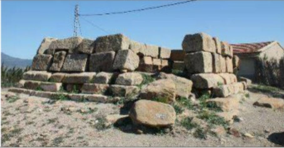
صورة رقم 1: قاعدة الضريح المدرجة.
