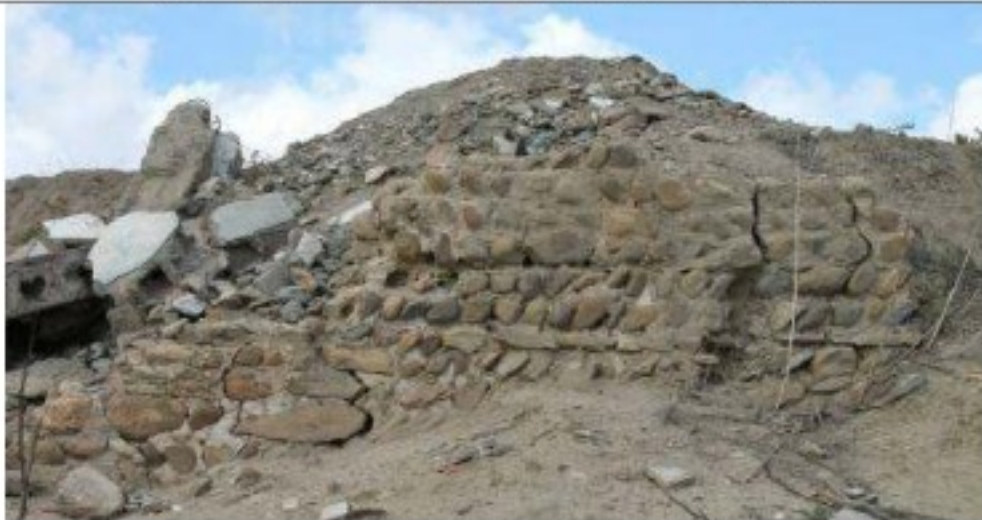
صورة رقم 7: بقايا جدار استعملت فيه تقنية Opus Sictil
