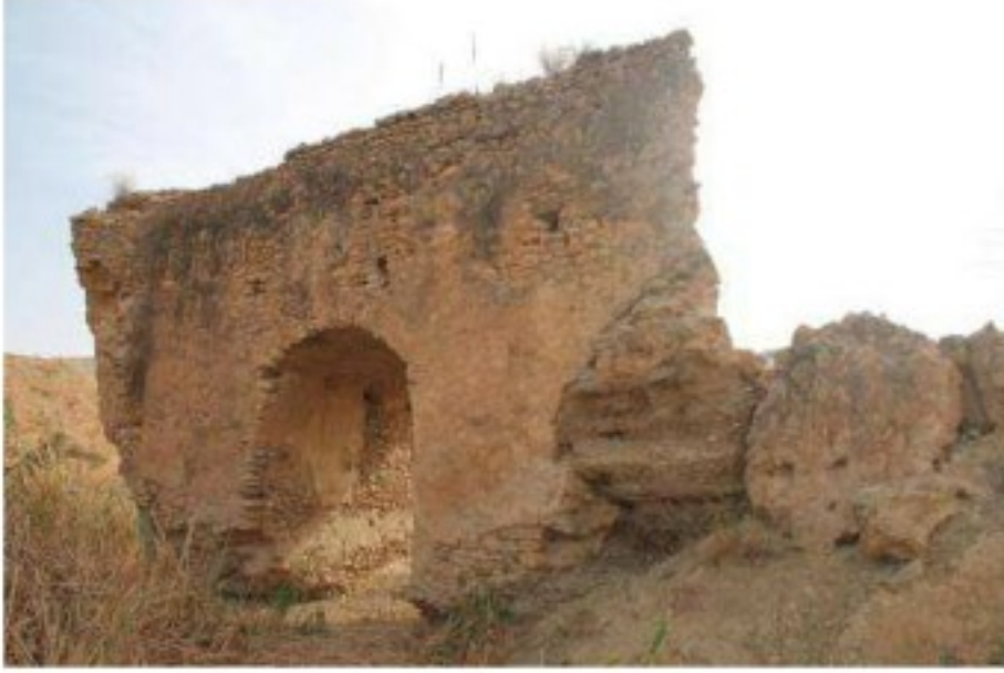
صورة رقم 3: بقايا القوس الذي تم غلقه في فترة لاحقة لبناء الجسر.
