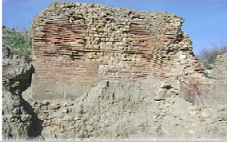
صورة رقم 5: استعمال الأجر في بناء زوايا الجدران.
