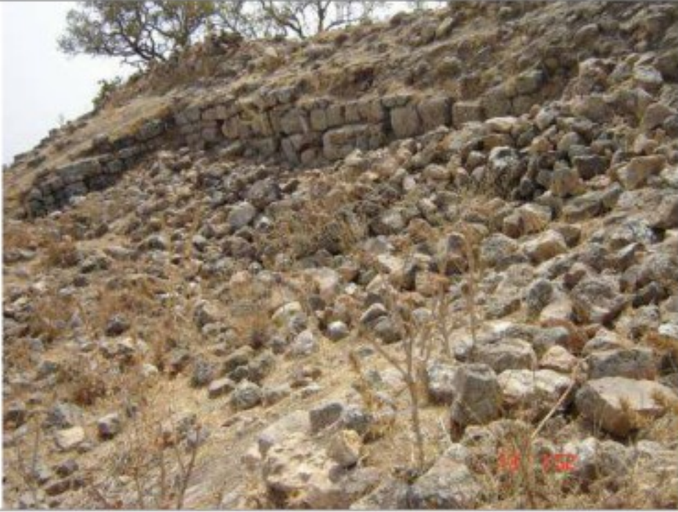
صورة رقم 3: بقايا الغرف الملتصقة بالجدار الثاني.
