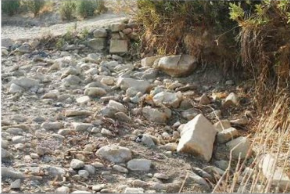
صورة رقم 8: جانب من حجر المقاطع المستعمل في بناء الجسر.
