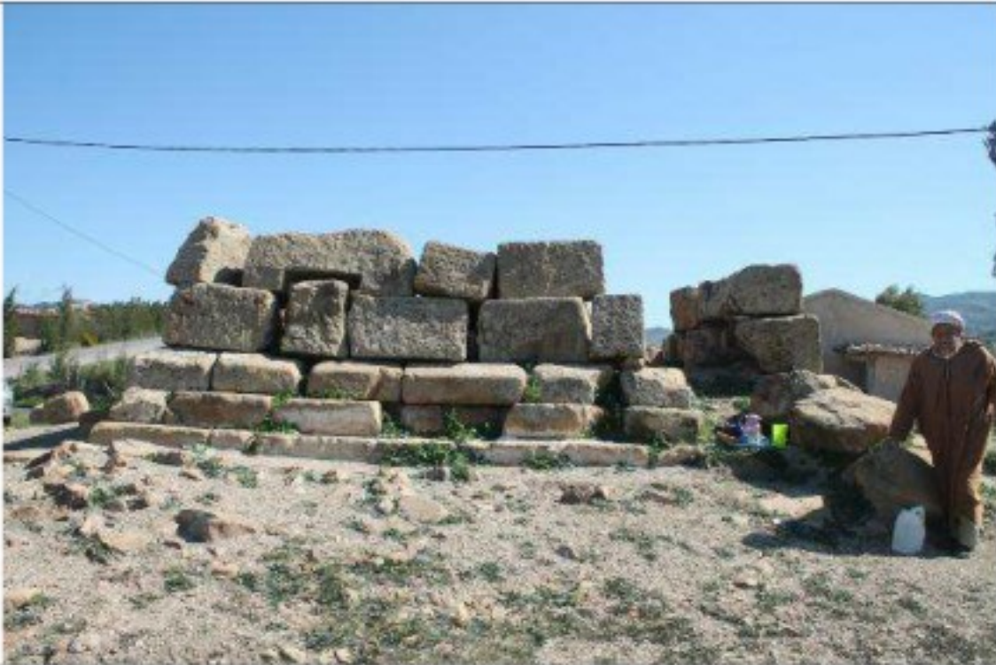
صورة رقم 4: النافذة التي تم سدها بحجر مقاطع.
