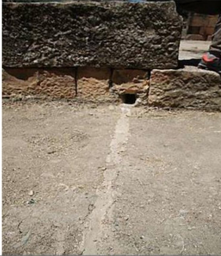
صورة رقم 19: بقايا القناة التي كانت تستعمل في تصريف المياه الزائدة عن الخزان إلا خارج القصر.
