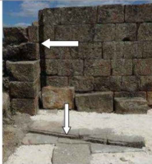
صورة رقم 18: قنوات نقل الماء من السقف إلى الخزان المائي.
