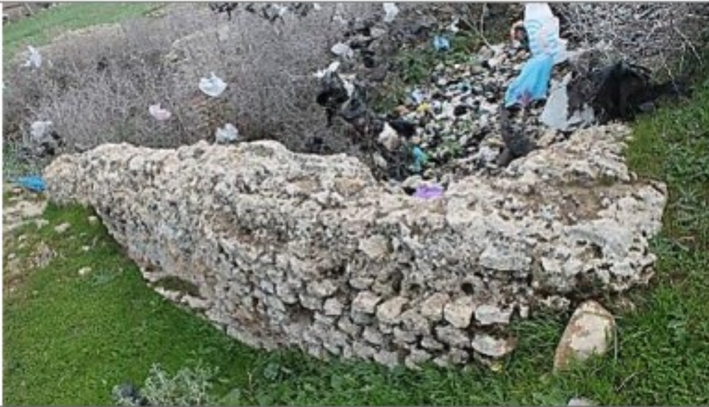
صورة رقم 9: تقنية Opus Incertum المستعملة في بناء الواجهات.
