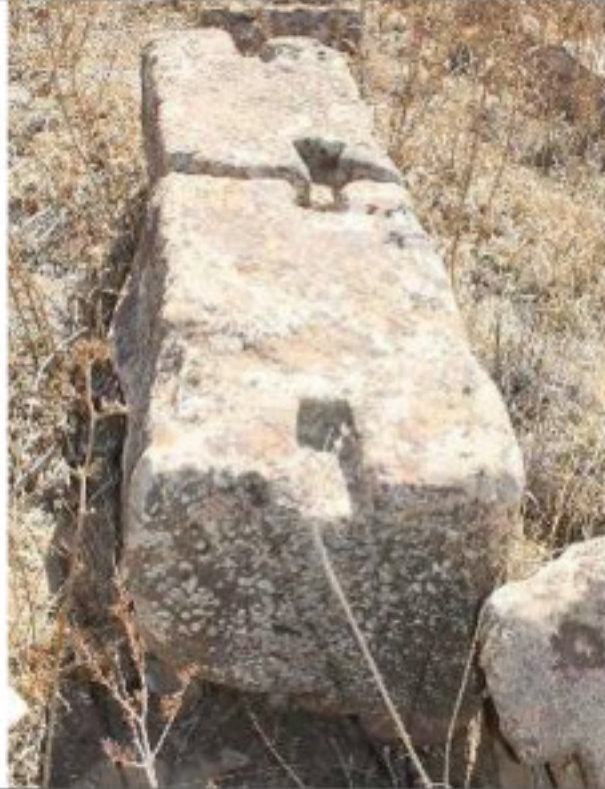
صورة رقم 2: تقنية ربط وتثبيت حجر المقامع.
