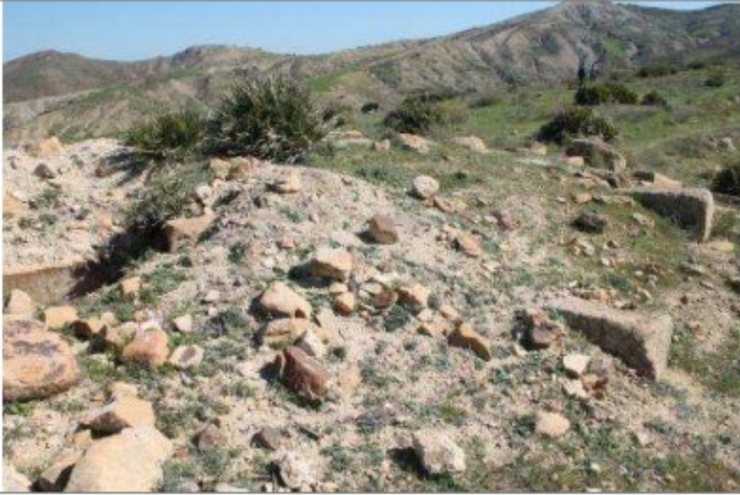
صورة رقم 10: جانب من بقايا البرج الموجود غرب قصر بوزولة (تعرض للتفتيب).
