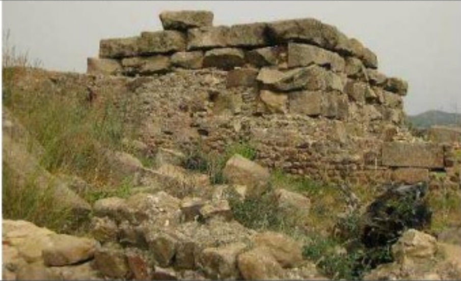
صورة رقم 20: اثار تهيئة الجدار الداخلي لوضع السقف.
