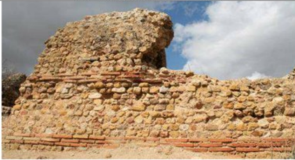
صورة رقم 6: استعمال الأجر في شكل احزمة في قاعدة ووسط الجدران.
