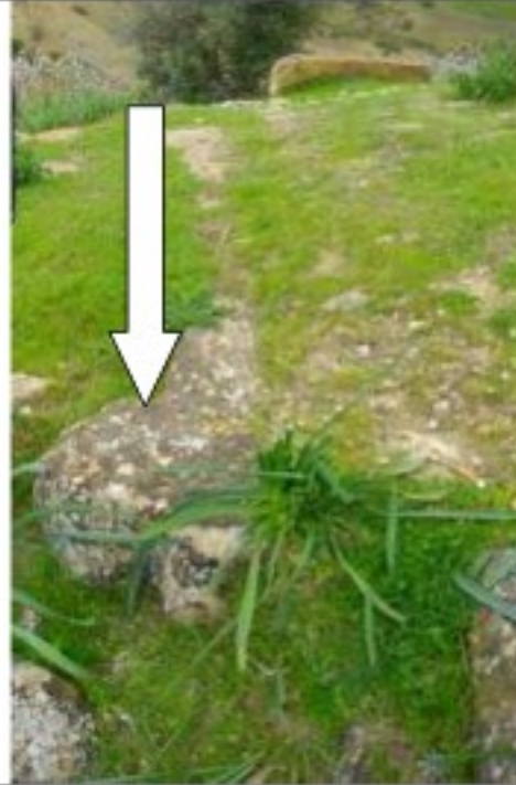
صورة رقم 2: اثار أعمدة مدمجة عند طرفي أسس البناية.
