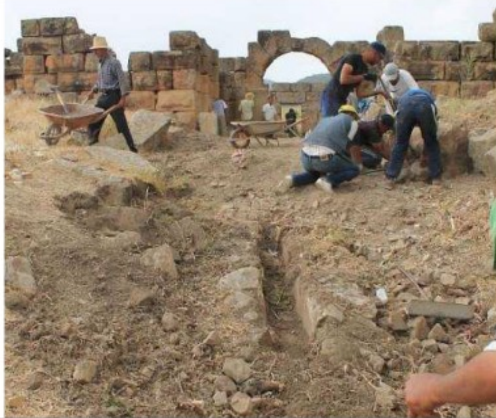
صورة رقم 6: بقايا قناة تصريف مياه القصر أثناء عملية التنظيف.
