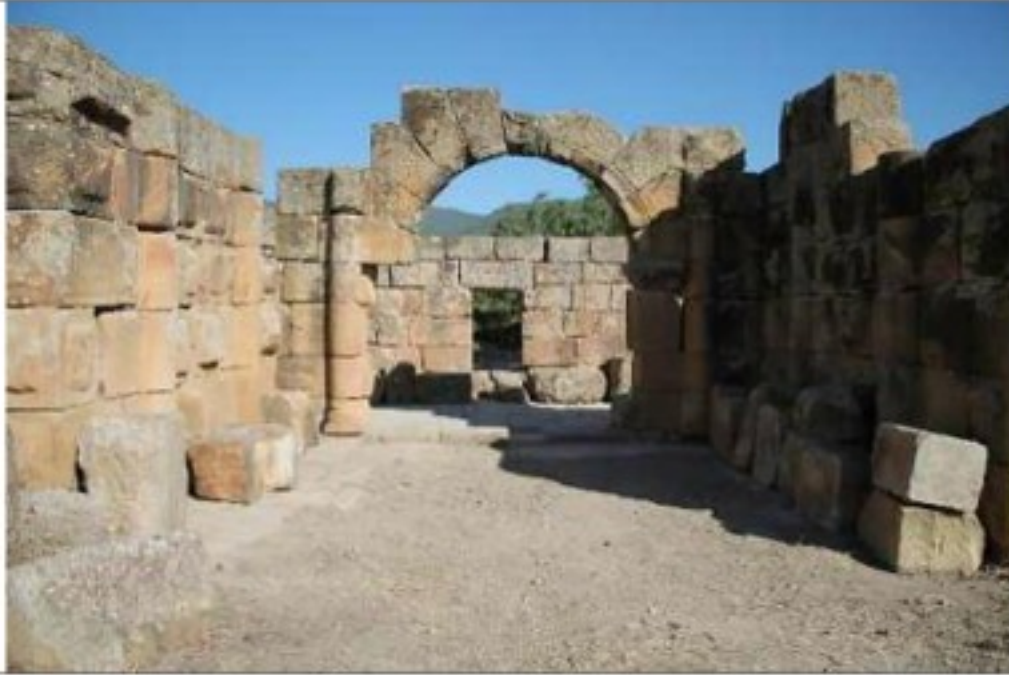
صورة رقم 5: منظر عام للفناء الموجود بين البرجين قبل عملية الترميم.
