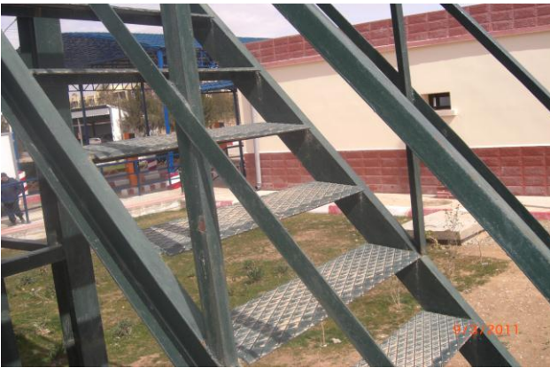
الصورة (21)، الصورة (22): الناحية الشرقية (تيسة-واد الصفصاف-): سلم من الحديد ضد التزج (anti dérapant) ولكنها حادة قد تتسبب في جرح العون إذا سقط
