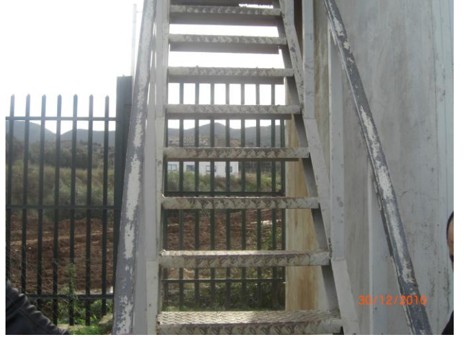
الصورة (19)، الصورة (20): سكيكدة المركز 2 : سلم مصمم بطريقة مختلفة عن المركز الأول، إلا أن حالته مُزرية و تتسبب في حوادث السقوط
