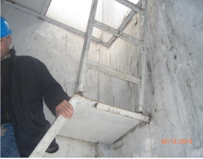
الصورة (17)، الصورة (18): سكيكدة المركز 1 : سُلّم مركز العمل غير مُصمم بطريقة جيّدة: سلم هش مصنوع من الحديد
