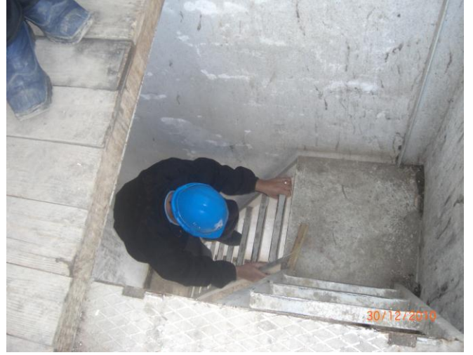
الصورة (17)، الصورة (18): سكيكدة المركز 1 : سُلّم مركز العمل غير مُصمم بطريقة جيّدة: سلم هش مصنوع من الحديد
