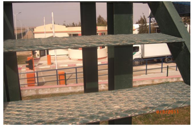
الصورة (21)، الصورة (22): الناحية الشرقية (تيسة-واد الصفصاف-): سلم من الحديد ضد التزج (anti dérapant) ولكنها حادة قد تتسبب في جرح العون إذا سقط
