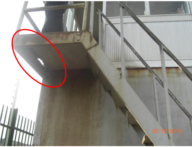
الصورة (19)، الصورة (20): سكيكدة المركز 2 : سلم مصمم بطريقة مختلفة عن المركز الأول، إلا أن حالته مُزرية و تتسبب في حوادث السقوط
