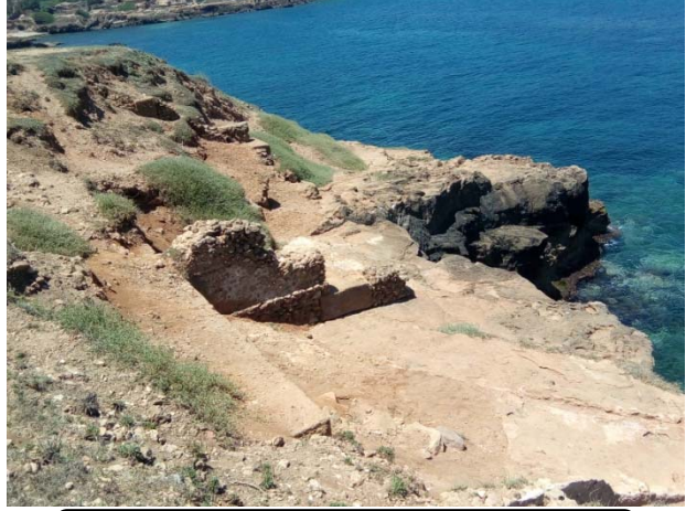
صورة 01: إنجراف أجزاء الجدران نحو البحر
