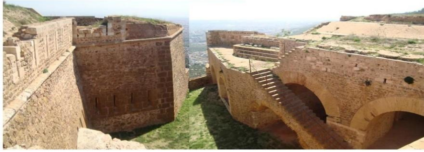
صورة(02): جزء من حائط الجهة الشرقية
