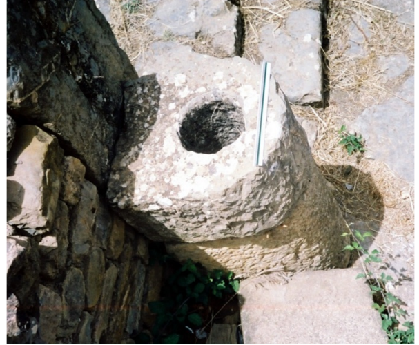
صورة(5): قناة لتصريف مياه الأمطار قرب المدخل الرئيسي لمنزل باخوس.
