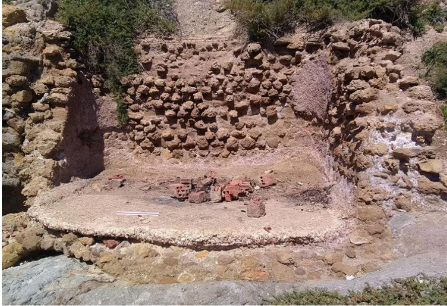
صورة 85: تفاصيل حوض رأس تيزيرين توضح تقنية البناء بالإضافة إلى طبقات الملاط المائي.
