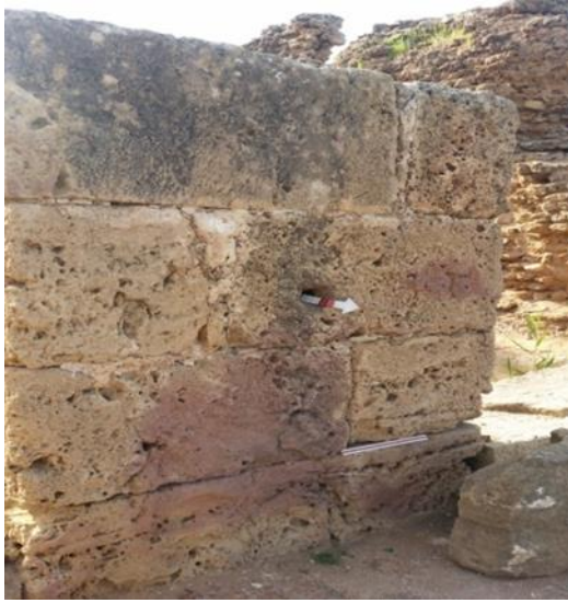
صورة 128: تقنية الحجارة المربعة بالورشة 02 من الزاوية الشرقية بتيابة.
