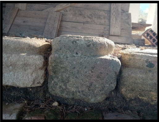
الصورة رقم 05: قواعد أعمدة
