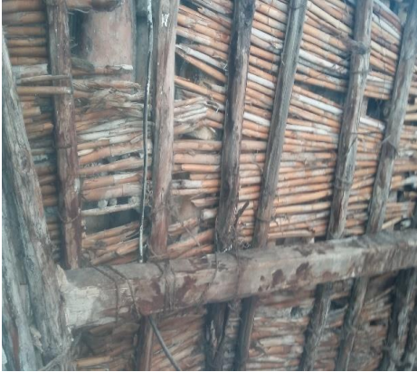
الصورة 04: سقف مشكل بالألواح الخشبية
