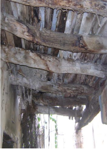
الصورة 02: سقف مشكل بالعوارض والأغصان الخشبية
