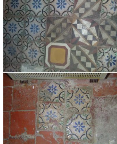
الصورة رقم (01): دمج البلاطات الخزفية في تبييط الأرضية
