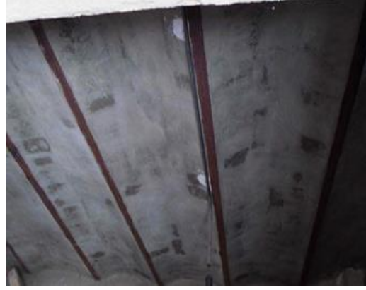
الصورة 03 : سقف مشكل بالعوارض الخشبية والقصب
