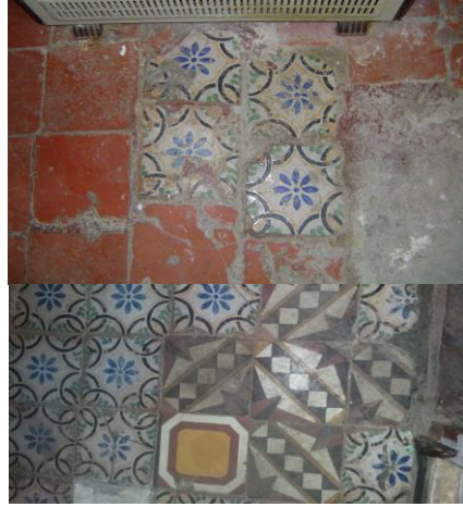
الصورة رقم (01): دمج البلاطات الخزفية في تبليط الأرضية
