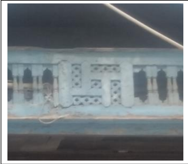
الصورة رقم (42): التعشيق والتجميع بالدرايزين بمسكن بن جلول
