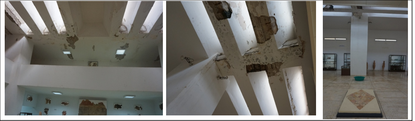
اللوحة رقم 03: تسلل الماء من السقف في متحف شرشال الجديد.
