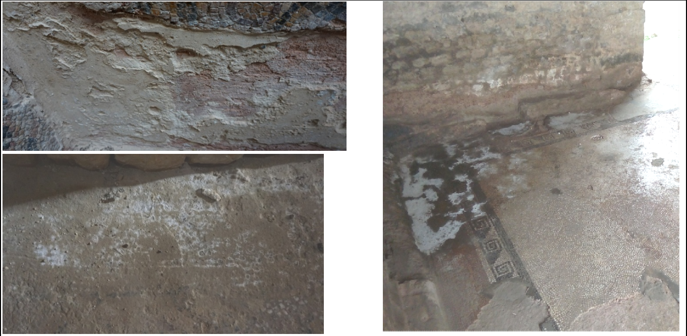
اللوحة رقم 04: انتشار الأملاح على فسيفساء الحمامات الجنوبية، متحف ومعمودية جميلة.
