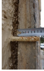
تثبيت الفسيفساء في الأرضية عرضة للمشحي. استعمال مثبتات معدنية قابلة للصدأ. تداخل وازدحام في عرض الفسيفساء
