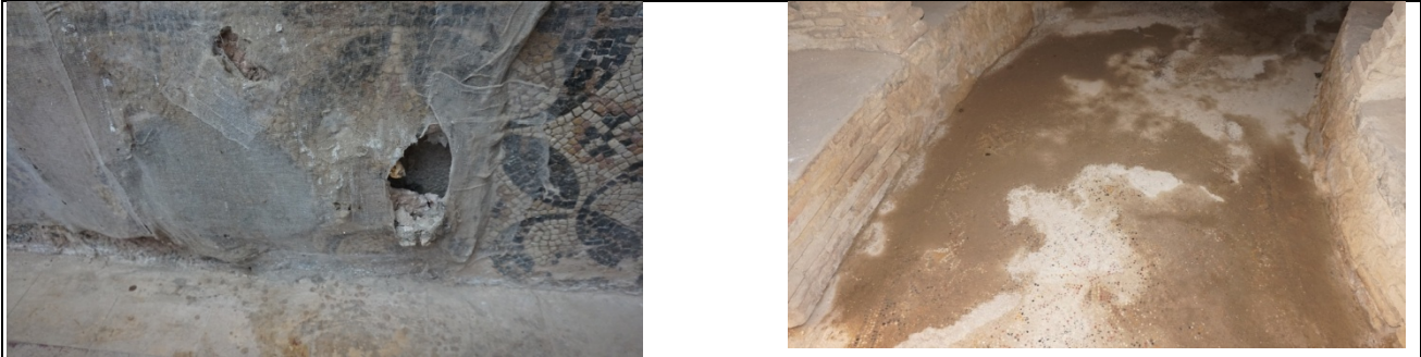
الصورة رقم 30: تأثير الماء على فسيفساء المعمودية بالصعود الشعيري وعلى فسيفساء المتحف بالرشح من الجدران بجميلة.
