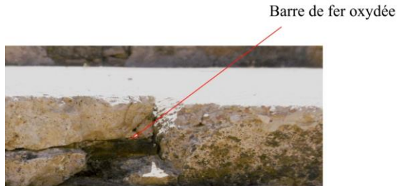
Fig. 2: barres de fers oxydés
