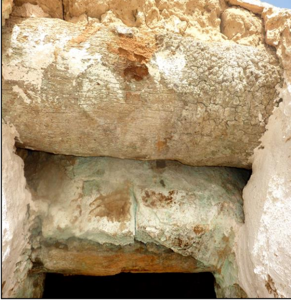
صورة 02: ساكف المدخل
