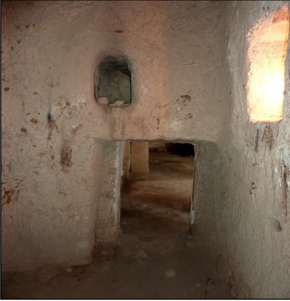
صورة 04: المدخل والنافذة والكوة
