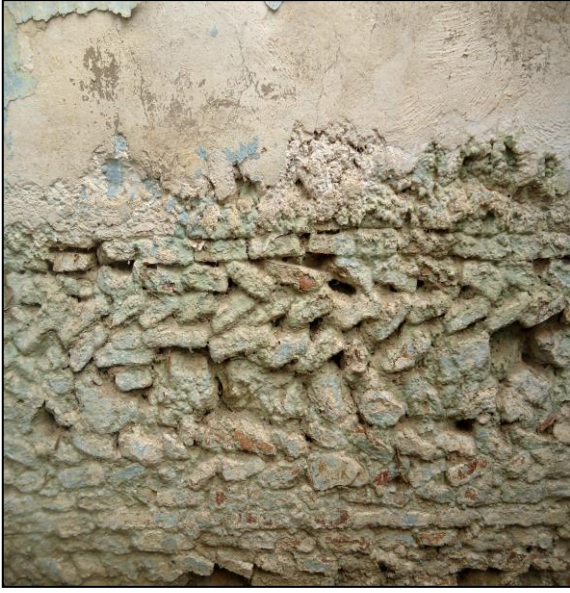
صورة 02: تقنية البناء
