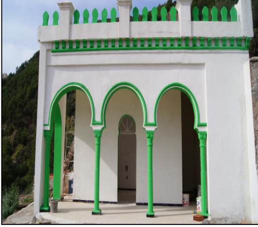
صورة 02: الواجهة الرئيسية والمدخل
