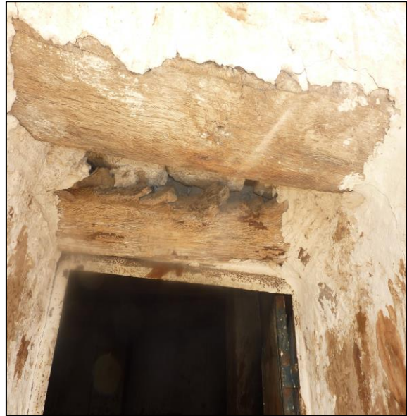
صورة 03: ساكف المدخل
