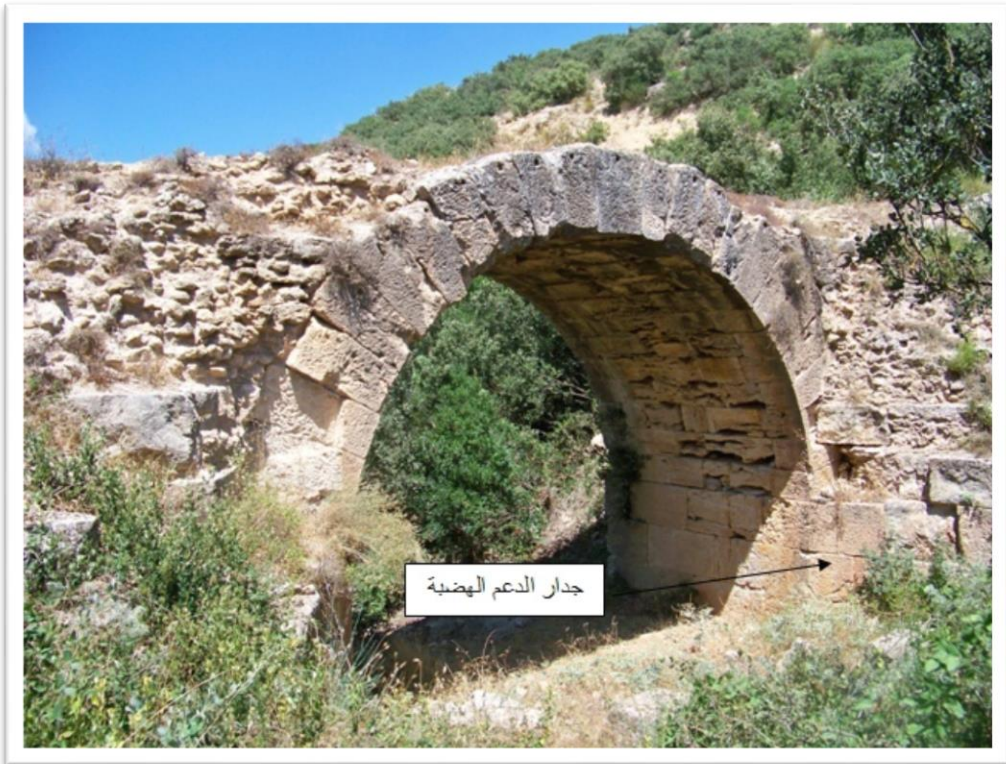
الصورة 118 جدار الدعم الهضبة مع عمادة القوس الشرقي. عن الطالبة
