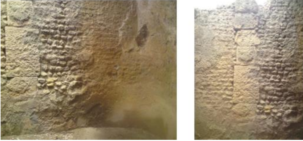
الصورة 90 دعامات جدران الخزان بالتقنية الإفريقية
