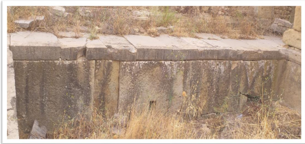
الصورة 209 قناة تدفق المياه الجهة الجنوبية. عن الطالبة
