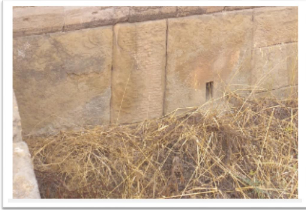
الصورة 207 فتاة تدفق المياه من جدار الشرقي الداخلي للحوض. عن الطالبة
