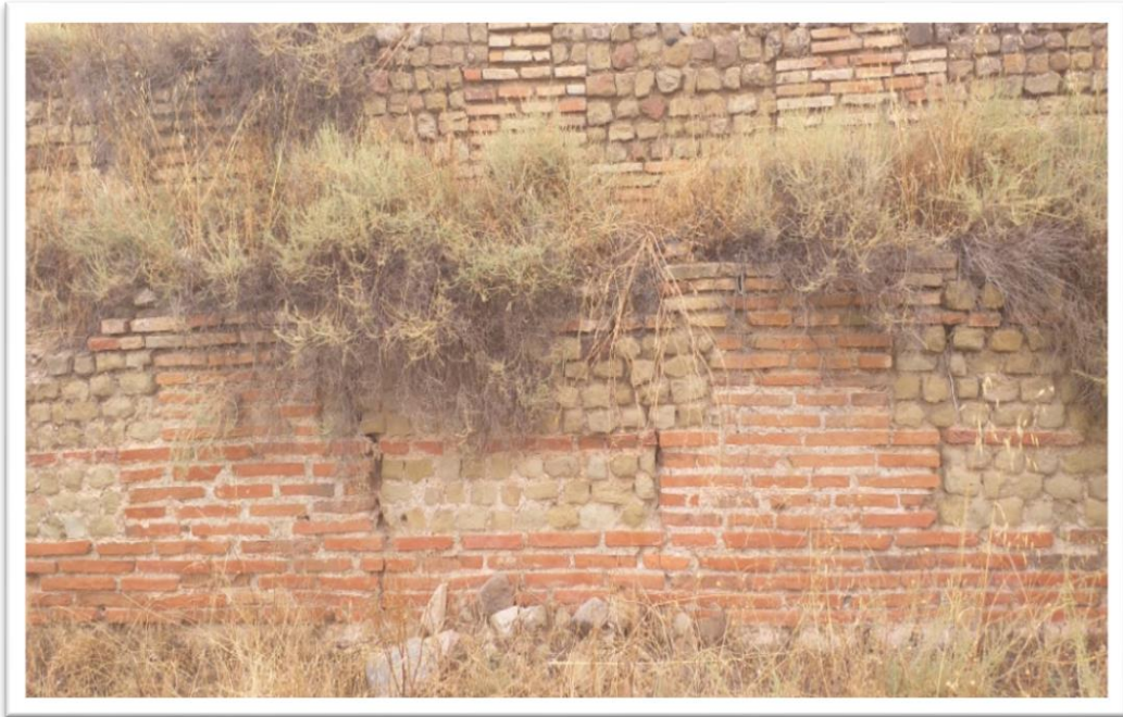
الصورة 167 آثار الجدار الخلفي للمعبد المركزي التقنية المختلطة. عن الطالبة
