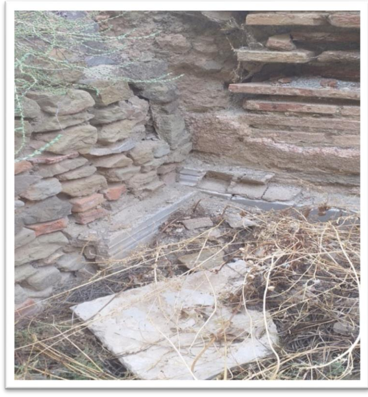
الصورة 196 جدار الشرقي و تقنية البناء لقاعة السيلا. عن الطالبة
