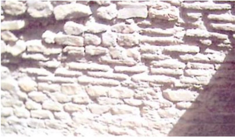
صورة 06 التقنية المختلطة خزان القنطرة عن الطالب
