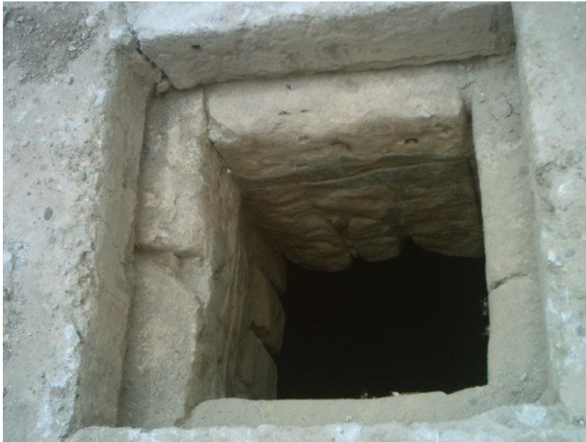
صورة 03 استخدام الحجارة المنحوتة خزان بادس (عن الطالب)
