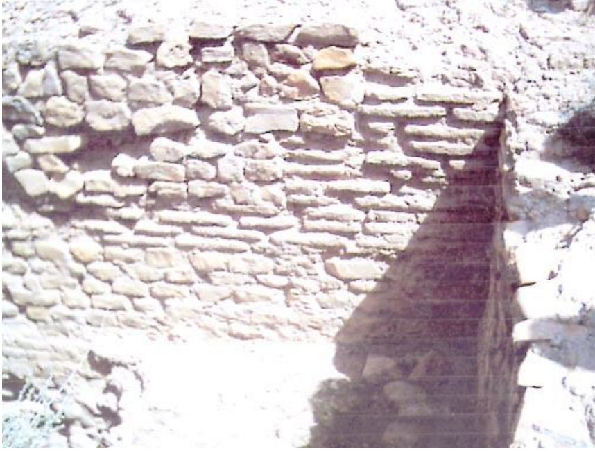
الصورة رقم 55 خزان اد دوفومينا (تصوير الطالب)
