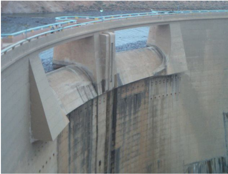
الصورة رقم 39 جدار سد فم الخرزة المقوس (تصوير الطالب )
