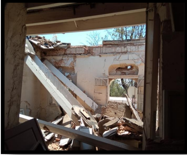
الصورة 54/ دار قايد الباب - غرفة الطابق الثاني -
