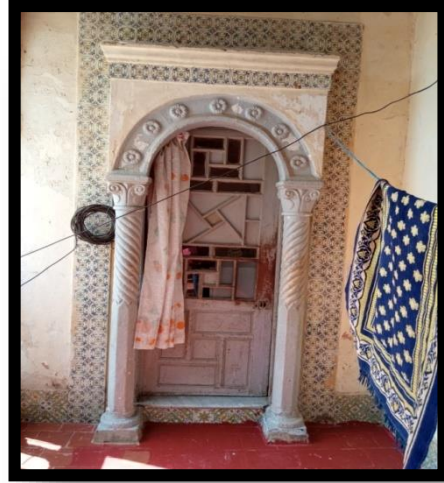
الصورة 89/ دار سكوتي - مدخل الغرفة رقم "07" -
