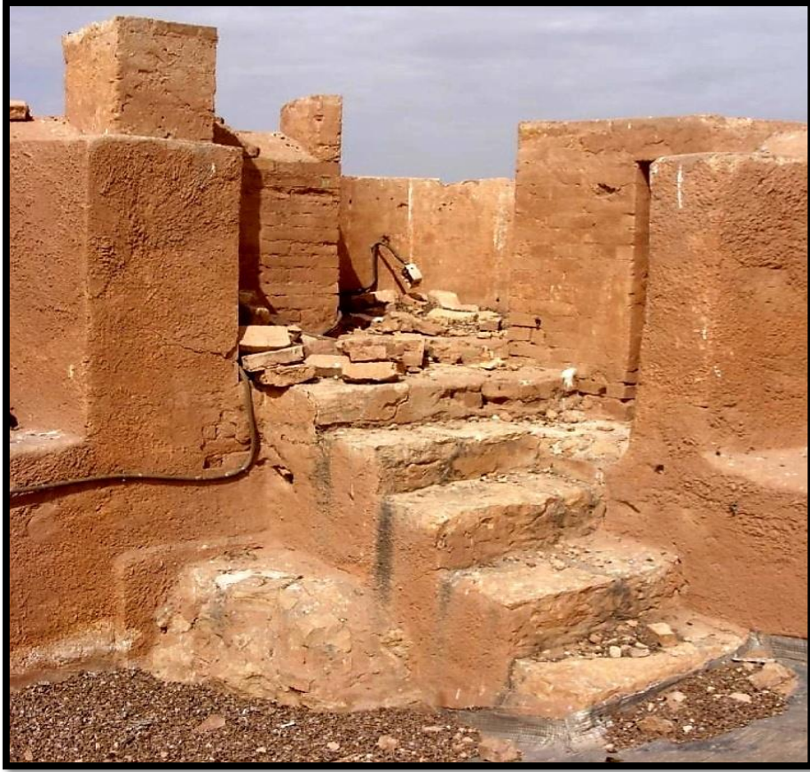
الصورة(27): انهيار جزئي لبرج المراقبة
