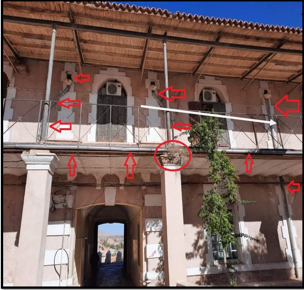
الصورة(13): قنوات الصرف الصحي (حصن بوسكارين)
