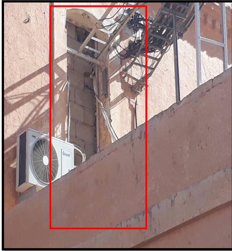
الصورة(14): غلق النوافذ باستعمال الاسمنت (حصن بوسكارين)
