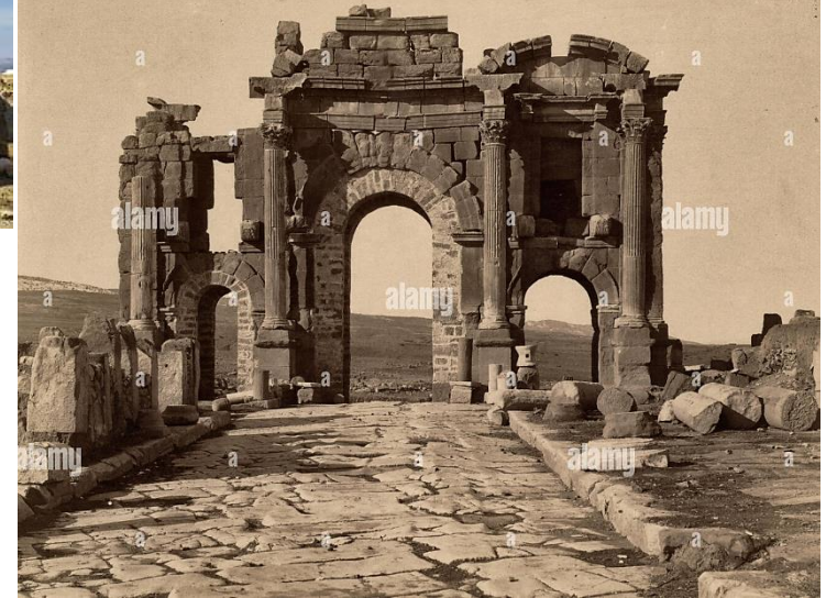
صورة21: بناية قوس النصر أثناء عمليات الترميم 1880م.
