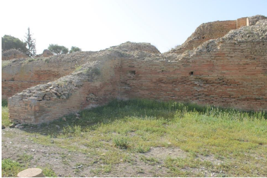
صورة 25 : تبين الدعامات الخارجية وأساسات الحمامات الكبرى الشمالية- تيمقاد منزل روماني. عن الطالب 2017.
