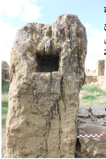
صورة 36: تفتت الحجارة الكلسية في شكل مسحوق، عينة بموقع القلعة البيزنطية، عن الطالب في 2018/05/05.
