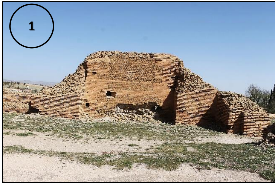
لوحة 35: نماذج لواجهات متنوعة، بمختلف مواد وتقنيات البناء، مع آثار الاهتراء البادية عليها. 1- واجهة مكشوفة بتقنية مختلطة تعاني من انهيار الجهة السفلى من الجدار بالحمامات الكبرى الشمالية / 2- الواجهة الشرقية لمدخل القلعة البيزنطية. عن الطالب في 2018/05/05.
