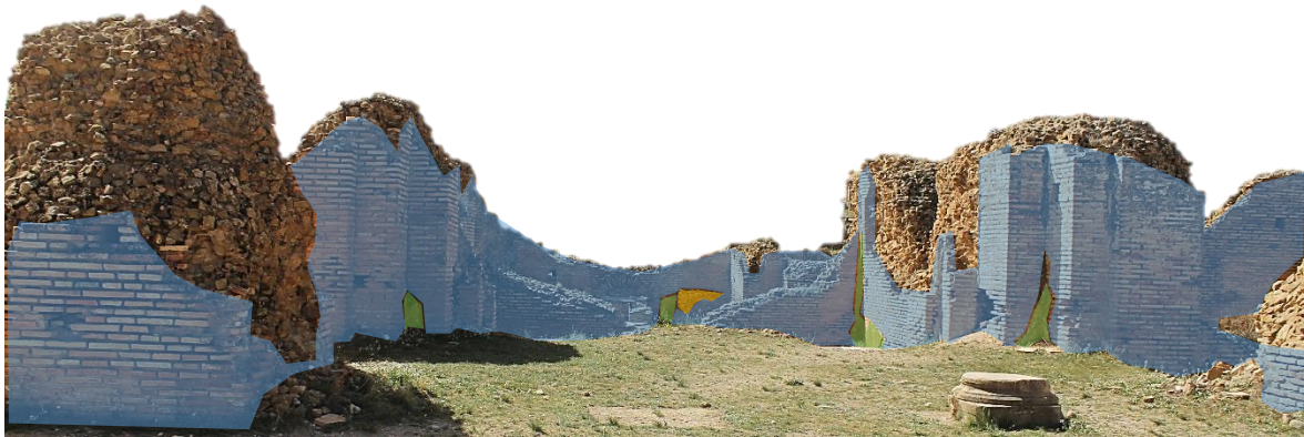
صورة 40: نموذج لتقنية البناء بالأجر، بالحمامات الكبرى الشمالية.
