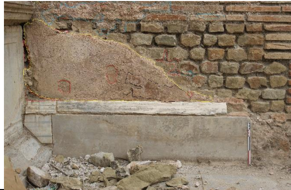
صورة 33: تلف التزيينات الجدارية بالزاوية الجنوبية الغربية من الكنيسة المسيحية بالقلعة البيزنطية. — طلاء ملون. — ملاط جبسي لتطبيق التلوينات الجدارية. — طبقة ملاط طيني تحضيري فوق الحجارة لتسوية الواجهة الجدارية. — آثار للملاط الجبسي. عن الطالب بتاريخ: 04/04/2018.
