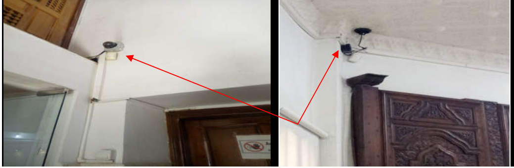
صورة 33: أجهزة تحسس درجة الحرارة المستخدمة بالمتحف.
