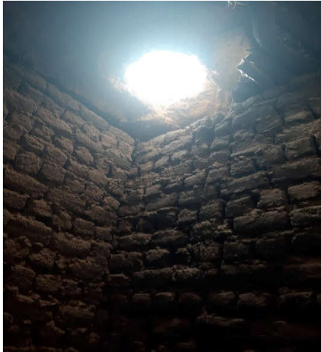
صورة 90: مظهر داخلي لقصر صورو.
