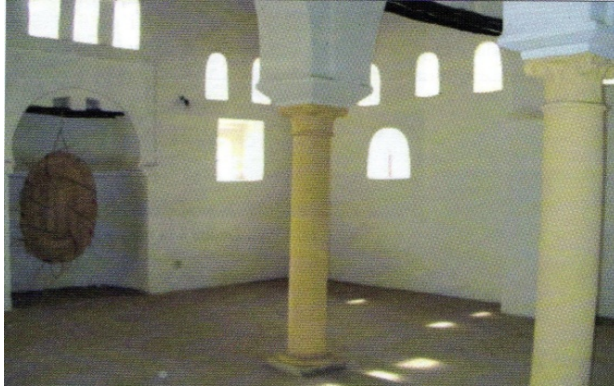
الصورة 01 : المظهر الداخلي لضريح سيدي هلال
