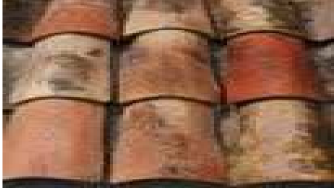
الصورة رقم 09 : طريقة ترتيب القرميد في السقف
