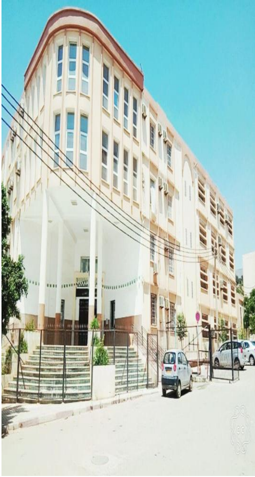
الصورة رقم ( 06 ) منظر خارجي لمبنى مدرسي بثانوية أبي ذر الغفاري
