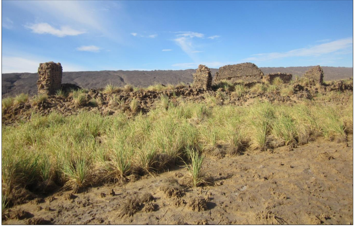
صورة 370: أنقاض مبنى عمارة قديمة بواحة على ضفة وادي جوغراف (صورة: ش/ج)
