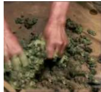
الصورة رقم 13: استعمال المثبتات في تقوية العجينة الطينية.
