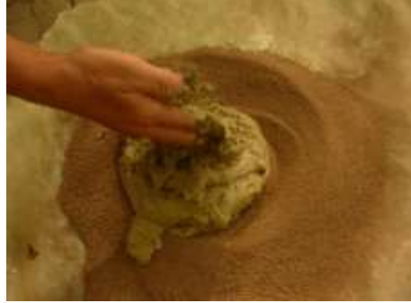
الصورة رقم 31: عملية تحضير العجينة الطينية - عن بوردوز وجليد-
