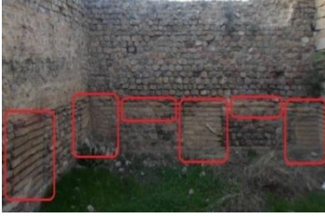
صورة رقم 045: تقنية البناء بالآجر وحجارة صغيرة منتظمة الشكل في القاعة 1 و2
