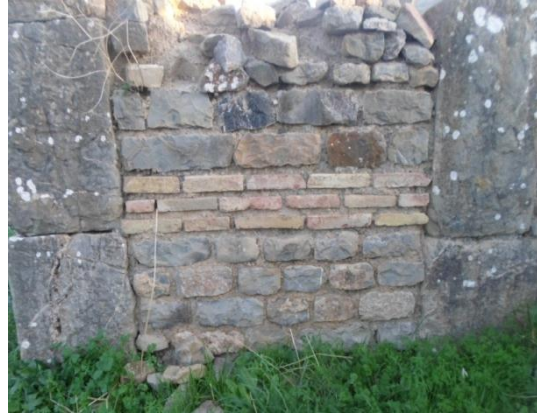
صورة رقم 862: التقنية الإفريقية تتخللها صفوف من الآجر
