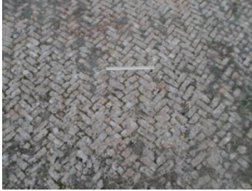
صورة رقم 395: التقنية المستخدمة في تبليط بهو والساحتين بالسوق الشرقي
