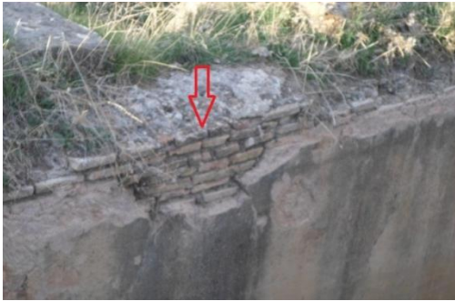
صورة رقم 041: الآجر بجدران خزانات المياه صورة رقم 042: سافات الآجر بجدار الخزان بحمامات كومود الثاني بحمامات كومود
