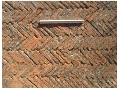
صور من رقم 354 إلى 356: تقنية تخطيط الأرضية بالآجر في معبد أكوا سيبتميانا فيليكس بمدينة تاموقادي
