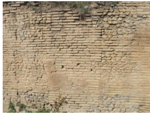
صورة رقم 073: تقنية بناء جدران القاعة الدافئة بالحمامات الشرقية لكويكول صورة رقم 074: الجدار الخلفي للقاعة الباردة المبني بالآجر والبلاط
