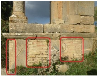
صورة رقم 248: الآجر بالواجهة السفلية اليسرى للنافورة
