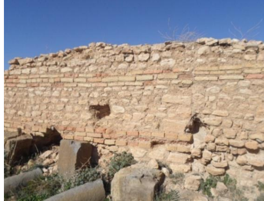
صورة رقم 858: جدران بالتقنية المزدوجة بحمامات الصيادين بلباريس
