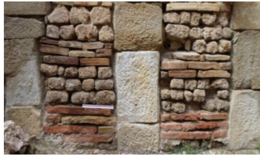
صورة رقم 035 و036: تقنية بناء الجدار الشمالي والجنوبي للقاعة الدافئة بالحمامات الشمالية الكبرى لمادوروس
