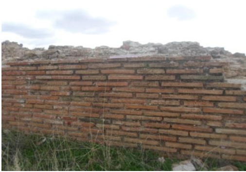
صورة رقم 857: جدران بتقنية التستاكيوم في معبد الكابيتول بتاموقادي
