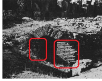
صورة رقم 300: قناة مياه
