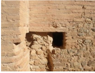
صورة رقم 181: الآجر والبلاط في جدار الحمامات الكبرى بلمباريس
