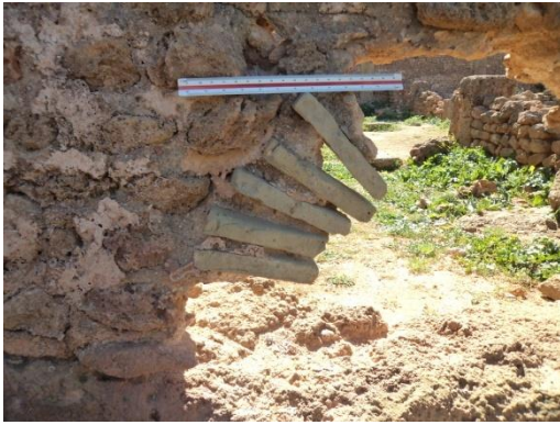
صورة رقم 329 و330: الأجر الموجود في قوس بالحمامات الخاصة بمنزل الجداريات
