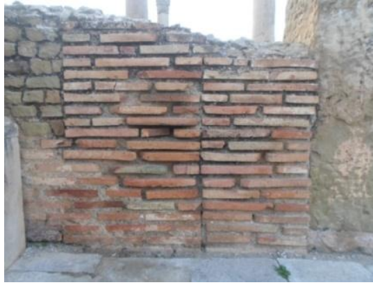
صورة رقم 404: تقنية استخدام الآجر في القاعة الرئيسية لمكتبة تاموقادي
