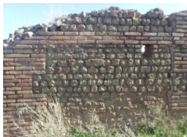
صور رقم 140 و 141: استخدام الآجر في الجدران الداخلية لحمامات فيلاديلف
