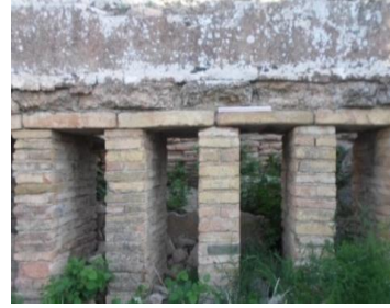
صورة رقم 779: البلاط في نظام التسخين تحت الأرضي بحمامات الكابيتول بكويكول
