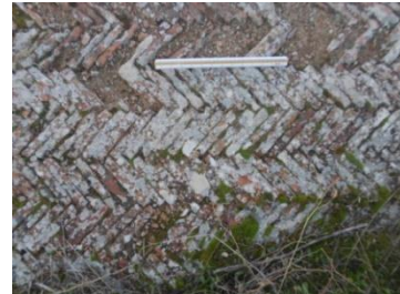
صور من رقم 354 إلى 356: تقنية تخطيط الأرضية بالآجر في معبد أكوا سيبتميانا فيليكس بمدينة تاموقادي
