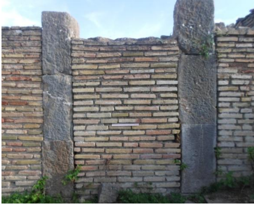
صورة رقم 863: التقنية الإفريقية بالآجر بمنزل الجدران من الآجر بكويكول
