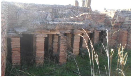
صورة رقم 870: الأعمدة الصغيرة من الآجر في نظام التسخين تحت الأرضي في الحمامات الصغرى الشمالية بتاموقادي
