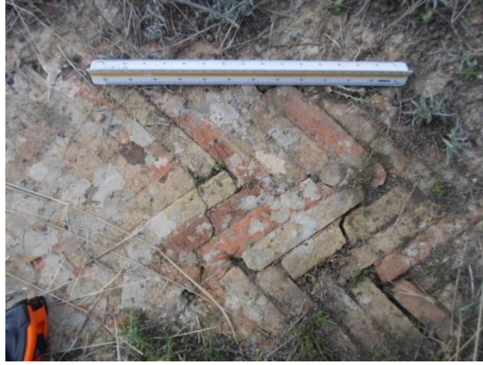
صورة رقم 309: تبليط الأرضية بتقنية السنبلة بمنزل سرتيوس بمدينة تاموقادي
