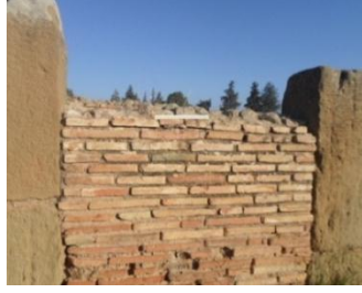
صور من رقم 088 إلى 090: تقنيات البناء بالآجر في الحمامات الشمالية الصغرى بتاموقادي
