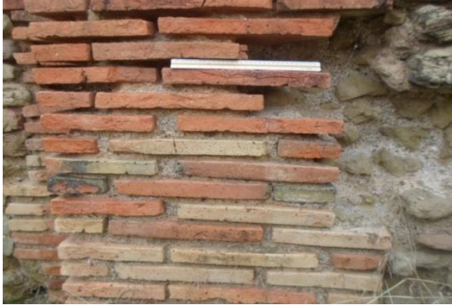
صور رقم 149 و150: طريقة استخدام الآجر في الجدران الداخلية والخارجية لحمامات الكابيتول
