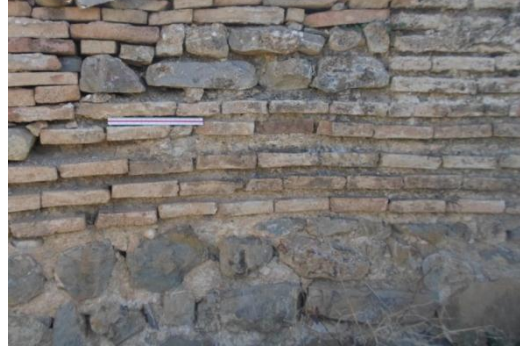
صورة رقم 384: تقنية بناء جدار الحنية بالإبازيليك المدنية بكويكول
