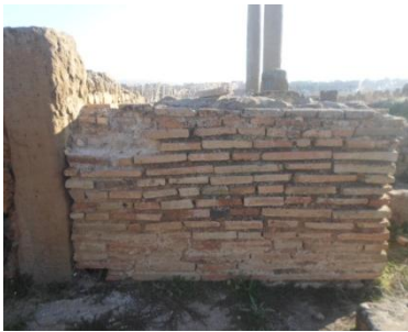
صورة رقم 317: تقنية البناء بالآجر في جدران الخاصة بالحمامات الخاصة بالمنزل الوحدة السكنية 18 بتاموقادي
