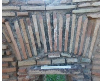
صورة رقم 780: البلاط بقوس الفرن بالحمامات الشمالية الكبرى لتاموقادي
