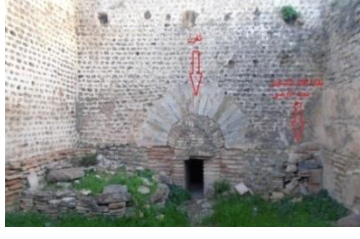
صورة رقم 044: بقايا الآجر في الفرن وفي نظام التسخين تحت الأرضي في القاعة 2
