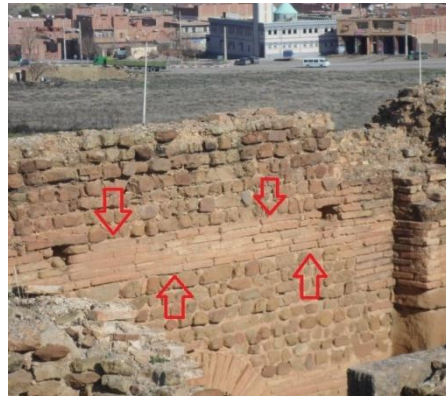
صورة رقم 110: وضعية الآجر في سافات في الحمامات الشرقية الصغرى
