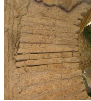
صورة رقم 070: البلاط المستخدم في فرن القاعة الساخنة صورة رقم 071: فرن القاعة الساخنة من البلاط صورة رقم 072: جدار من الآجر مع تلييسة أصلية في القاعة الساخنة
