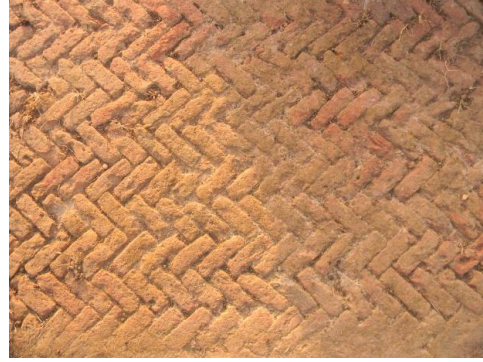
صورة رقم 866: تبليط أرضية الحوض النصف دائري بموقع الجزر الثلاث بتقنية السبيكاتوم
