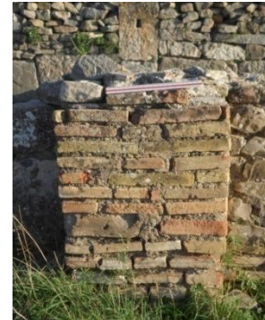
صورة رقم 268: دعامة من صفوف الآجر بحمامات منزل الحمار المنتصر
