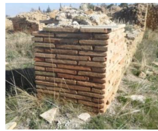
صورة رقم 139: تقنية استخدام الآجر في حمامات فيلاديلف
