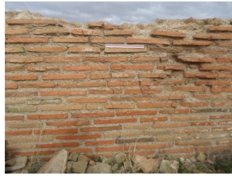
صورة رقم 352: تقنية بناء الجدران القاعات المخصصة لآلهة معبد الكابيتول بتاموقادي
