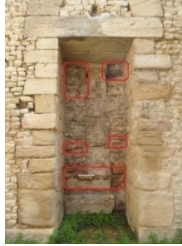
صورة رقم 031: إعادة استعمال للبلاط وللأعمدة الصغيرة من الآجر
