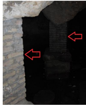
صور رقم 028 و 029: ركائز من الآجر في الفضاء السفلي للحمامات الشمالية الكبرى لهيبون
