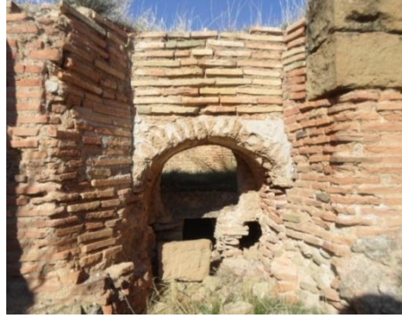
صور رقم 105 و106: بقايا نظام التسخين تحت الأرضي بالقاعة الساخنة
