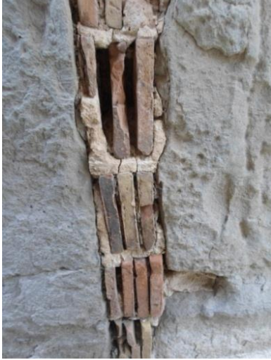
صورة رقم 037: إعادة استعمال الآجر في مدخل القاعة الدافئة بالحمامات الشمالية الكبرى لمادوروس
