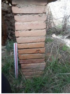
صورة رقم 162: عمود من الآجر في نظام التسخين تحت الأرضي بالحمامات الغربية لتاموقادي
