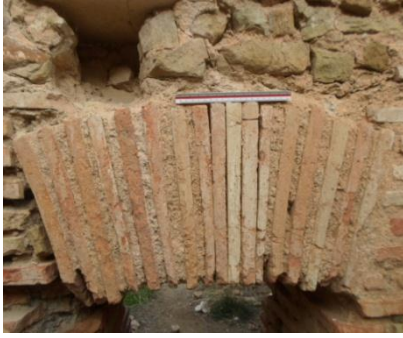
صورة رقم 351: تقنية بناء أقواس ممرات القاعات
