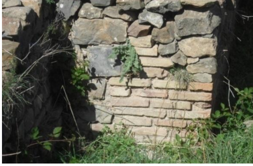
صورة رقم 087: سافات الاجر التي استخدمها بحمامات ترانتيوس في مدينة كويكول
