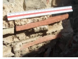
صورة رقم 083 و 084: القرميد المقوس في الجدار الشمالي للقاعة 8 بحمامات المعمودية بكويكول
