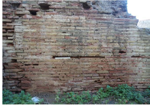
صورة رقم 856: جدران بتقنية التستاكيوم في الحمامات الكبرى لقيصرية
