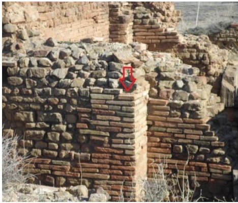
صورة رقم 111: الآجر المستعمل في زوايا الجدران بالحمامات الشرقية الصغرى لتاموقادي
