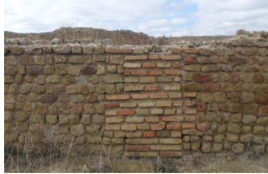
صور رقم 149 و150: طريقة استخدام الآجر في الجدران الداخلية والخارجية لحمامات الكابيتول
