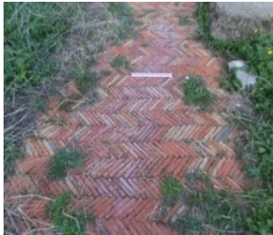
صور من رقم 354 إلى 356: تقنية تخطيط الأرضية بالآجر في معبد أكوا سيبتميانا فيليكس بمدينة تاموقادي
