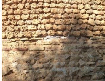
صورة رقم 250: سافات الآجر في الجزء النصف الدائري من نافورة لحوريات
