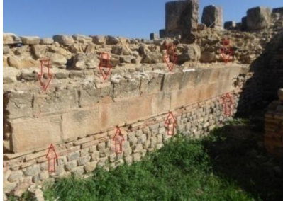
صورة رقم 085: الجدار الذي استخدم فيه المعماري القرميد المسطح والمقوس
