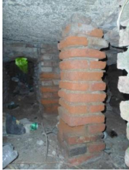
صورة رقم 027: آجر مستطيل الشكل في نظام التسخين
