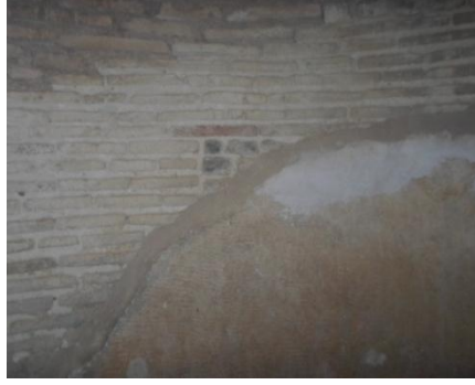
صورة رقم 370: جدار مبني بالآجر وغطى بتلبيسه أصلية بالمعمودية بالحي المسيحي لكويكول
