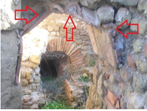
صورة رقم 113: استخدام القرميد المسطح والمقوس في قوس الباب في الحمامات الشرقية الصغرى بتاموقادي
