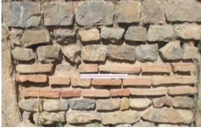
صورة رقم 276: تقنية استخدام الآجر في جدران منزل أمفترت
