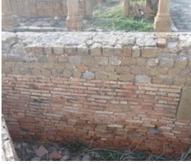
صورة رقم 116: الآجر والحجارة في الحمامات الصغرى الوسطى بتاموقادي
