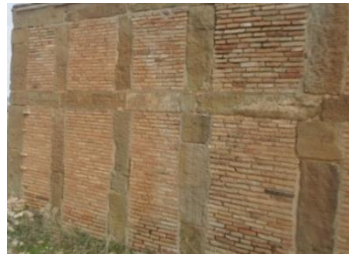
صورة رقم 379: إعادة استخدام الآجر القديم في بناء جدران غرفة بيت التعميد
