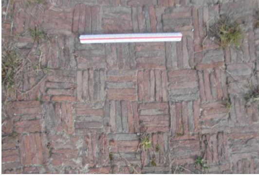
صورة رقم 867: تبليط نافورة الفوروم بهيون بتقنية السبيكاتوم
