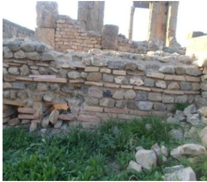
صورة رقم 270: استخدام الآجر والقرميد المسطح في جدار القاعة 4 في منزل الحمار المنتصر
