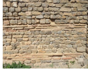
صورة رقم 285: تقنية استخدام الآجر بجدران منزل أوروب
