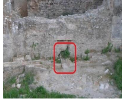
صورة رقم 734 و 735: القرميد المقوس لنقل وصرف المياه في الحمامات الجنوبية الكبرى بكويكول وخزان موقع الجزر الثلاث
