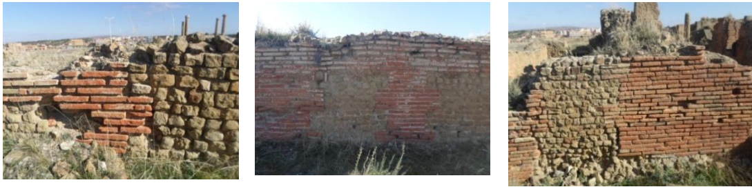
صور رقم 102 إلى 104: تقنية استخدام الآجر في جدران الحمامات الشرقية الكبرى
