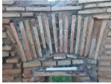
صورة رقم 134: البلاط المستخدم في بقايا فرن بالحمامات الكبرى الشمالية لتاموقادي
