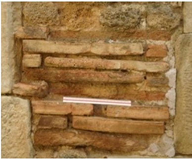
صورة رقم 035 و036: تقنية بناء الجدار الشمالي والجنوبي للقاعة الدافئة بالحمامات الشمالية الكبرى لمادوروس
