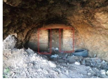
صورة رقم 253: دعامات الآجر في الخزان الأول
