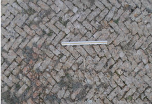
صورة رقم 865: تبليط أرضية بالسوق الشرقي بتاموقادي بتقنية السبيكاتوم
