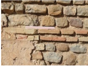
صورة رقم 077: الآجر والبلاط بجدار الحوض بحمامات المعمودية
