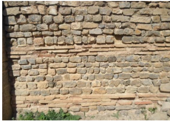
صورة رقم 860: جدران بالتقنية المزدوجة في منزل أوروب بكويكول
