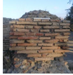
صورة رقم 124: يوضح تقنية بناء جدران الحمامات الشمالية الكبرى بتاموقادي
