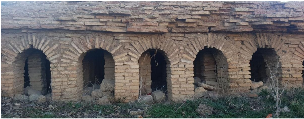
صورة رقم 872 و 873: نظام التسخين تحت الأرضي بحمامات المعسكر بلمباريس
