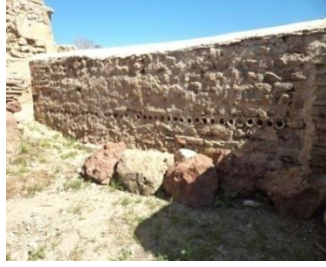
صورة رقم 229: الجدار الذي يحتوي على الأنابيب في الفرن الثاني للحمامات
