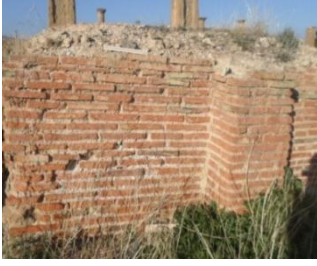
صور من رقم 088 إلى 090: تقنيات البناء بالآجر في الحمامات الشمالية الصغرى بتاموقادي
