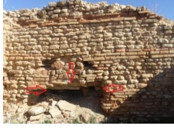
صورة رقم 190: بقايا لنظام التسخين تحت الأرضي مع بلاط يحمل ختم الفرقة الثالثة الأوغسطسية
