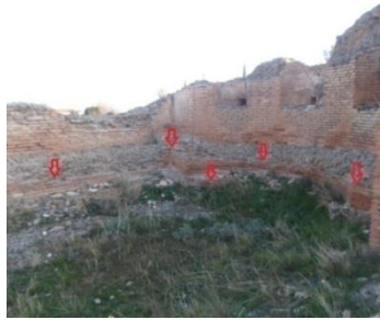
صورة رقم 128: سافات الأجر في الجهة الداخلية للأحواض بالحمامات الشمالية الكبرى بتاموقادي
