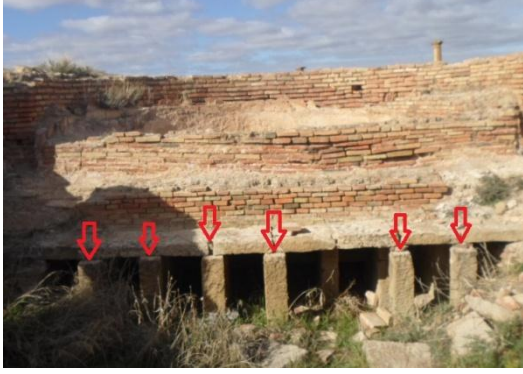
صورة رقم 871: الأعمدة الصغيرة من الحجارة في نظام التسخين تحت الأرضي بالحمامات الجنوبية الكبرى لتاموقادي
