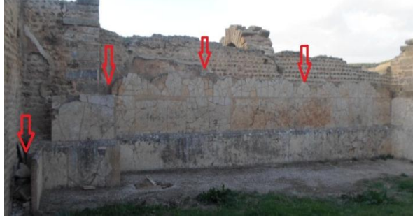
صورة رقم 049: الجدار المزدوج بالقاعة الدافئة للحمامات الجنوبية لمدينة كويكول
