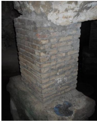
صور رقم 028 و 029: ركائز من الآجر في الفضاء السفلي للحمامات الشمالية الكبرى لهيبون
