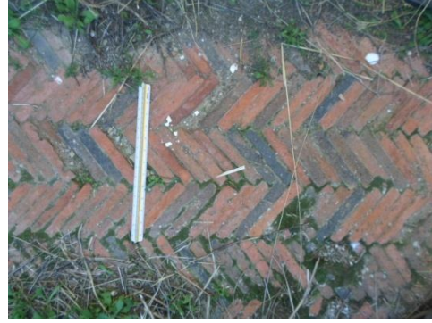
صورة رقم 864: تبليط أرضية معبد أكوا سيبتيما بتقنية السبيكاتوم
