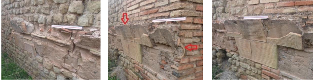
صور من رقم 153 إلى 155: القرميد المسطح والمقوس بجدران حمامات الكابيتول
