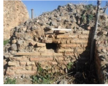
صورة رقم 179: تقنية بناء الجدران بالحمامات الكبرى بلمباريس
