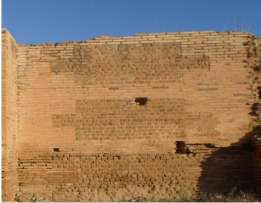
صورة رقم 859: جدران بالتقنية المزدوجة في الحمامات الشمالية الكبرى بتاموقادي
