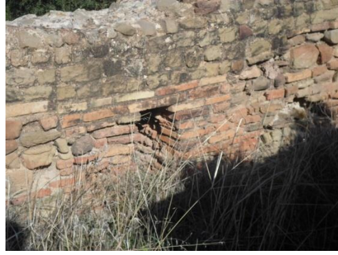
صور رقم 100 و101: تقنية البناء بالآجر مع الحجارة في الحمامات الصغرى الشمالية الشرقية بتاموقادي
