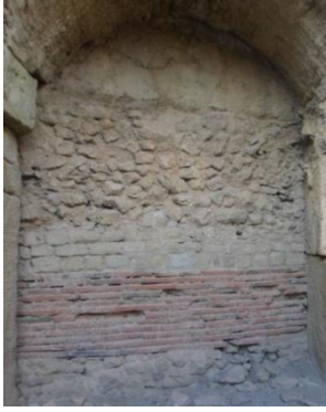
صور من رقم 175 إلى 177: مواد بناء الطين المشوي في الجزء السفلي للحمامات الجنوبية الكبرى لتاموقادي
