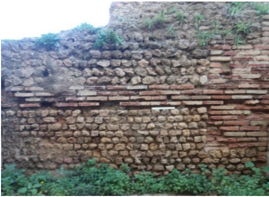
صورة رقم 861: جدران بالتقنية المزدوجة في الحمامات الكبرى للقيصرية
