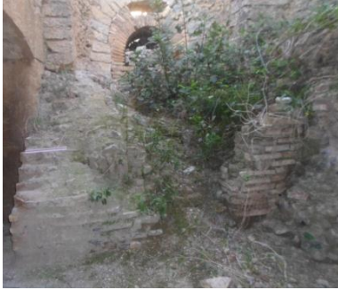
صورة رقم 059: الأجر المستخدم في مدخنة الجنوبية للحمامات
