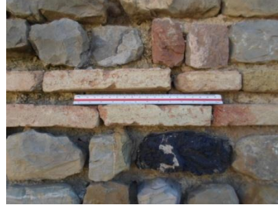
صورة رقم 081: سافات الآجر بحمامات المعمودية القاعة 8
