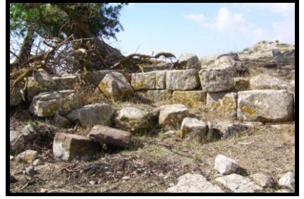
صورة-7- : بقايا السور التحصيني (F)
