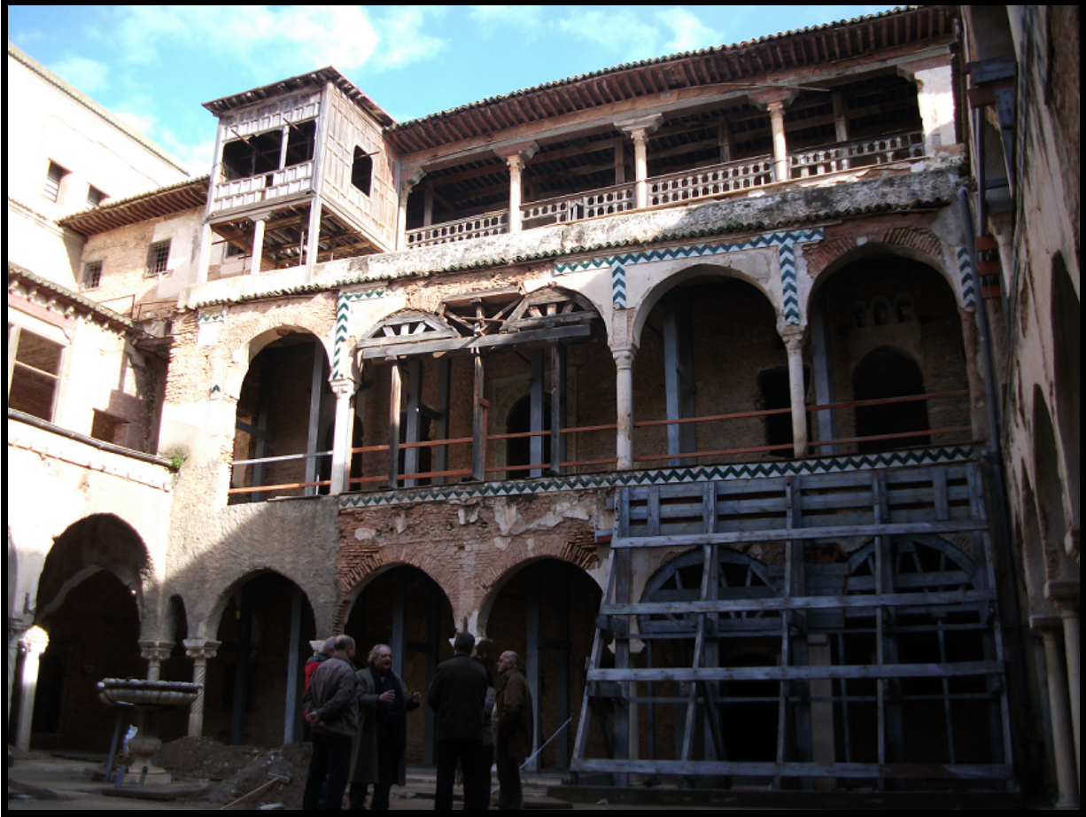
اللوحة رقم (66): منظر جانبي للواجهة الشرقية المطلة على صحن قصر الداوي بدار
