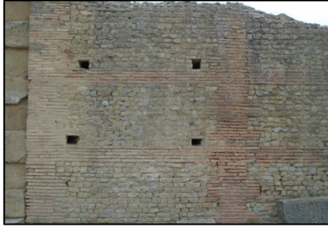
الصورة 41: آثار جسرات السقالة. عن الطالب
