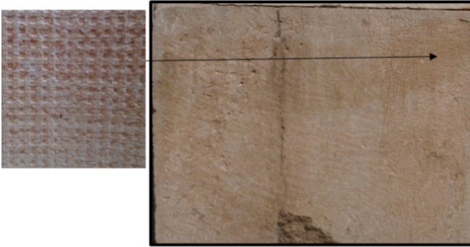
الصورة 21 : آثار المطرقة المسننة (المكتبة العمومية) عن الطالب
