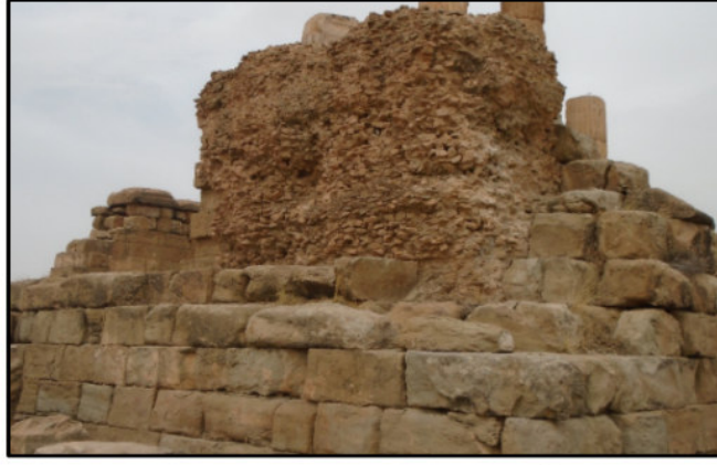
الصورة 43: عملية تكديس لحجارة الدبش الخام الممزوج بالملاط على كتل حجرية مصقولة في بناية الكابيتول. عن الطالب
