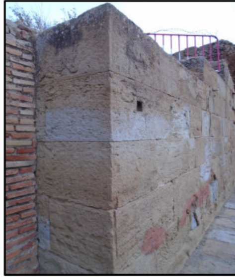
الصورة 28 استخدام للمروضوم الكبير في بناية المسرح، المتماسك بفعل ثقله عن الطالب
