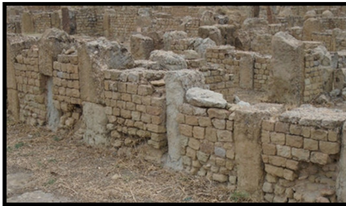
الصورة 44 : استخدام لحجارة الدبش المنتظم متوسط الحجم
