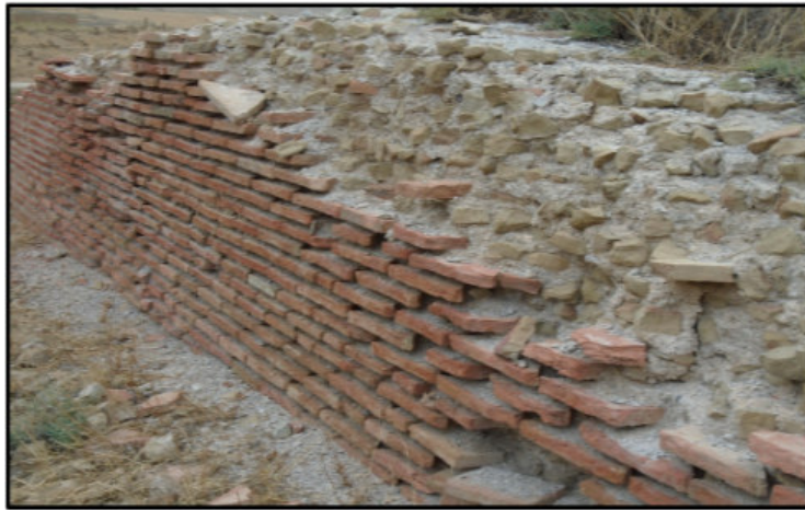
الصورة 38 : التقنية المختلطة، من الدبش الخام مع الأجر عن الطالب
