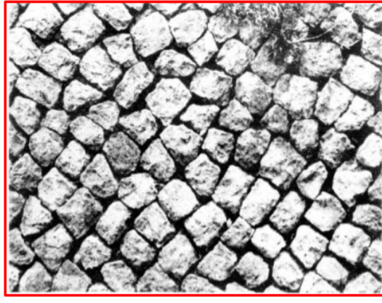
الصورة 45: تقنية الشبه الريتيكولاتوم
