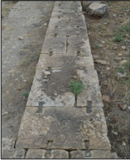
الصورة 29 نظام المروضوم الكبير المرسخ بواسطة وصلات معدنية، ذات شكل ذيل السنونو معبد الكابيتول . عن الطالب
