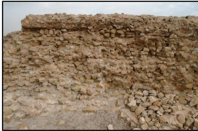
الصورة 42 : تقنية الحجارة غير المنتظمة، المسرح. الطالب
