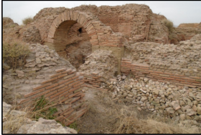
الصورة 39: التقنية المختلطة القائمة على كل من الدبش الخام و الأجر المعتمدة في الحمامات الشمالية الكبيرة . عن الطالب
