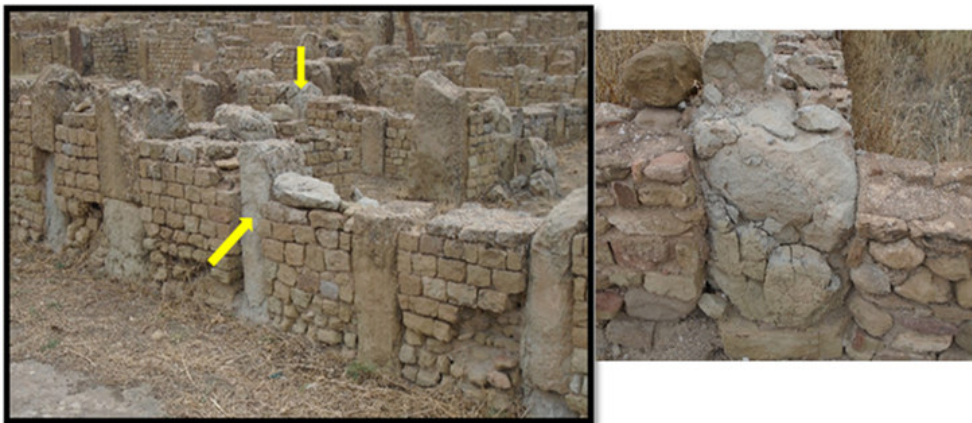
الصورة 32 استخدام للقطع الحجرية ذات التركيبة الطينية عن الطالب
