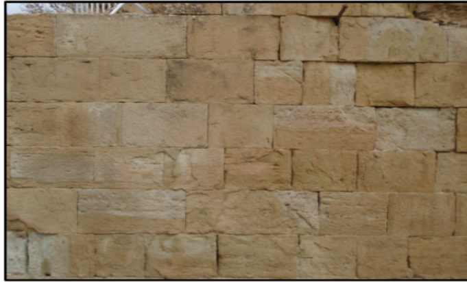
الصورة 02 : تقنية بناء الجدران بدون استخدام للمادة الرابطة
