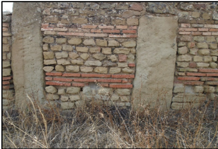
الصورة 37: التقنية الإفريقية و أشرطة قطع الأجر (الطالب)
