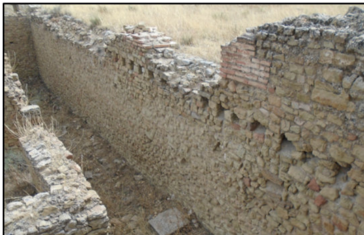
الصورة 4 : بقايا لأثار ثقوب العوارض الخشبية . الطالب
