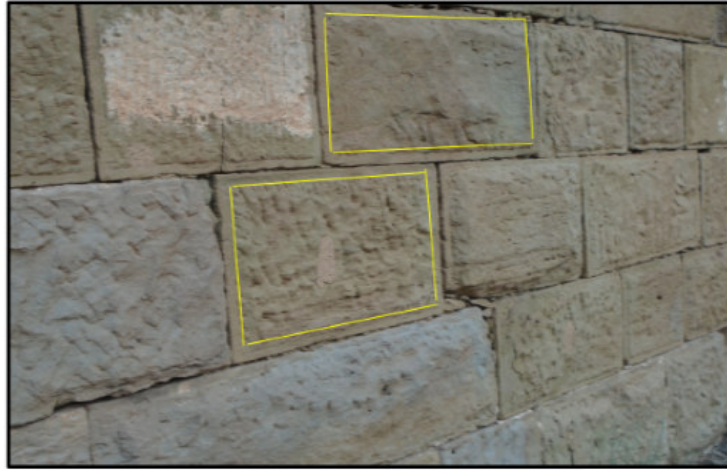
الصورة 12 التزيين بواسطة أشرطة جانبية مع المظهر الخشن في الوسط الطالب
