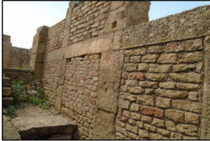
الصورة 36: التقنية الإفريقية ذات الهيكل الحجري المعتاد (إطار) بمدينة ثموقادى . عن الطالب
