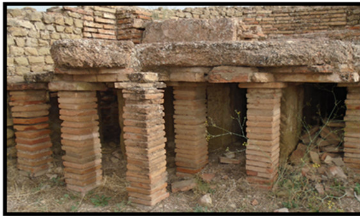
الصورة 51 . استخدام قطع الأجر في تشكيل أعمدة مراحل القاعات
