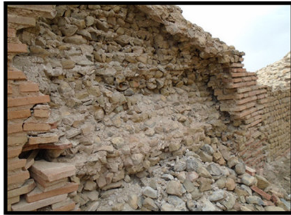
الصورة 12 استخدام الملاط في حشو
