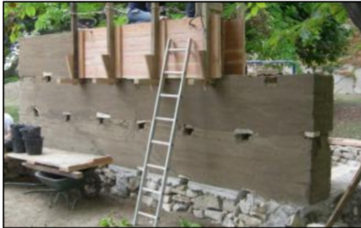
الصورة 3 : تقنية الردم باستخدام البطانات الخشبية
