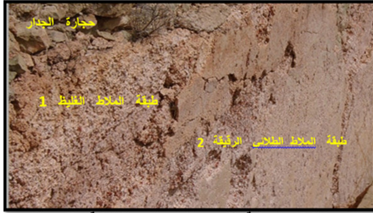
الصورة 57 عملية تلبس الواجهات الداخلية للجدران
