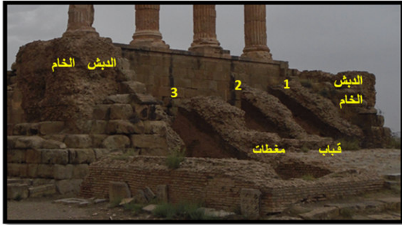
لصورة 55 معبد الكابيتول من الواجهة الأمامية، تظهر القباب المغطية و المكتشوفة و الكوافة الدبشية الجانبية عن الطالب
