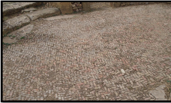
الصورة 50 تبليط أرضية المدخل الرئيسي للسوق الشرقي، بقطع
