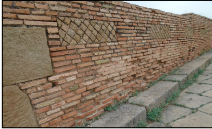
الصورة 47 : تقنية الحجارة المنتظمة الزوايا في جدار الحمامات المركزية . عن الطالب
