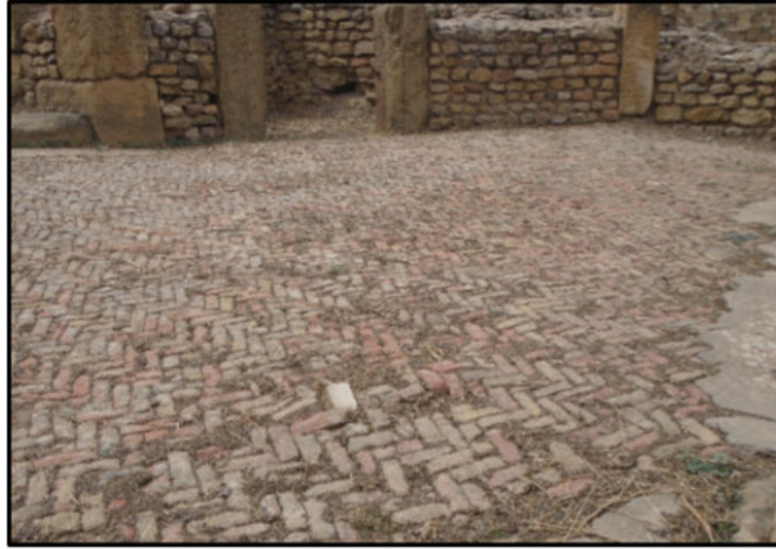
الصورة 52 تقنية حسكة السمكة المعمدة في السوق الشرقي عن الطالب
