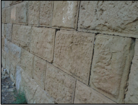
الصورة 31 نظام الإزودوم الخالي من التزيينات المسرح عن الطالب الصورة 32 نظام الإزودوم ذو التزيينات معبد الكابيتول الطالب
