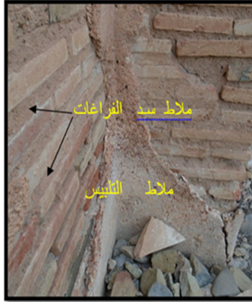
الصورة 11 نوعي الملاط، التليس و سد الفراغات بين مواد كتلة الجدار المبني بمادة الأجر . الحمامات الشمالية الكبيرة لمدينة تيمقاد عن الطالب
