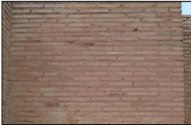
الصورة 48 : تقنية صفوف قطع الأجر، المستخدمة في الحمامات الشمالية الكبيرة . عن الطالب
