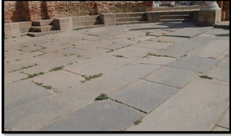
الصورة 41: أرضية المكتبة المبلطة بالحجر الكلسي الأزرق
