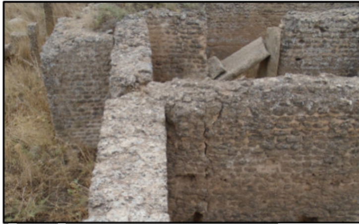
الصورة 14 تقنية الحجارة غير المنتظمة الزوايا الطالب
