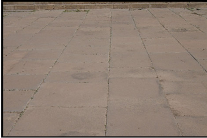
الصورة 39: أرضية الساحة العامة المبلطة ببلاطات حجرية بشكل منتظم . عن الطالب
