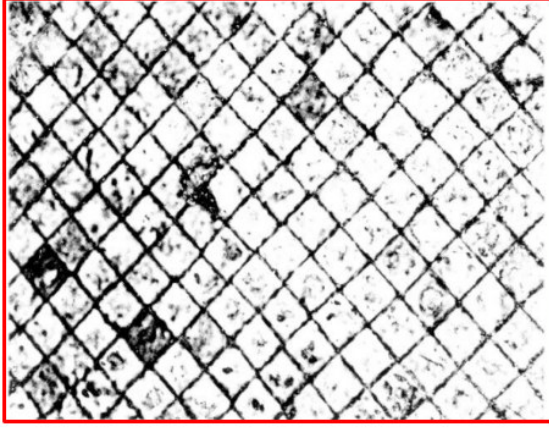
الصورة 46 : تقنية الريتيكولاتوم
