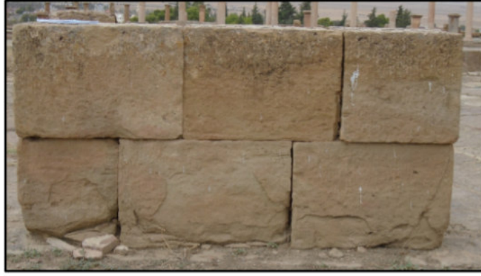
الصورة 19 استخدام لمطرفة الصقل (المسرح) عن الطالب
