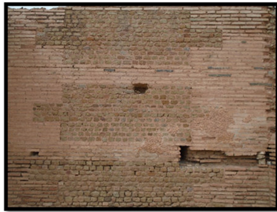
الصورة 03: استخدام لقطع لأجر على واجهات الجدران الصورة 04 : كواة ذات عدة حلقات و أحزمة الداخلية للحمامات الشمالية الكبيرة لمدينة تموقادي أجرية عن Adam(J-P ),op.cit,p 153. عن الطالب
