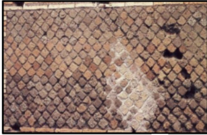
الصورة 6 : تقنية الريتيكولاتوم
