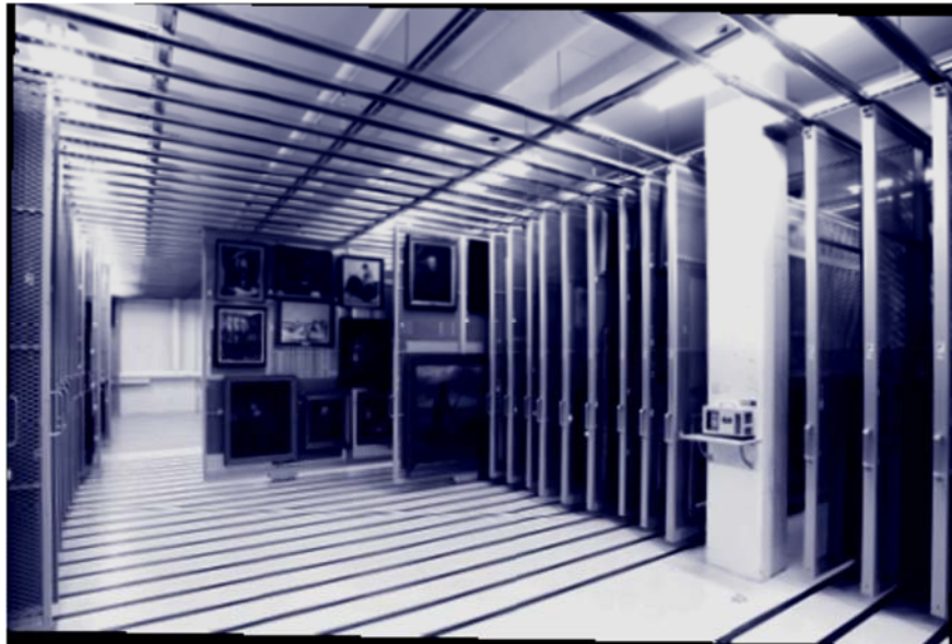
الصورة رقم 21: نظام التخزين باستخدام الشاشات المنزلة، عن Pierre Bouvier, Les institution muséales :Rénovation, Construction, Agrandissement.
