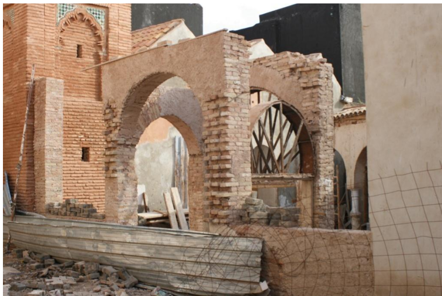
صورة رقم 42- منظر خارجي لمسجد أولاد الإمام بتلمسان أثناء أعمال الترميم 2014 (من عمل الطالبة)
